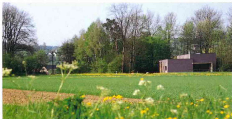
Pumpstation «Gugel» Anblick von Norden
