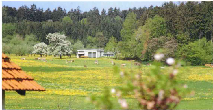
Pumpwerk Maltbach von Südosten gesehen
