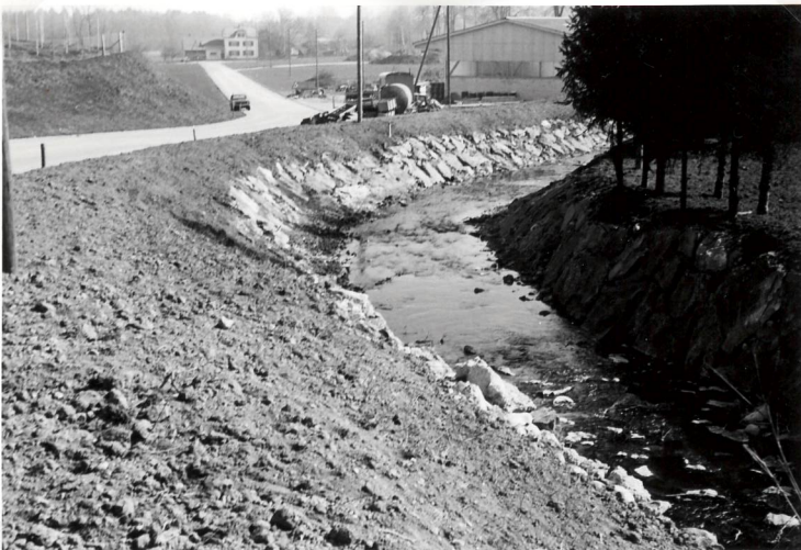
Neu angelegtes Alpbach-Bett Der neue Bachlauf wurde nach Nordwesten verlegt, damit für die Erweiterung der ARA zu- sätzliches Ausbauareal gewon- nen werden konnte.
