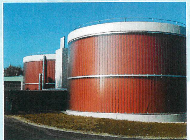
Faulraum und Schlammstapelturm
