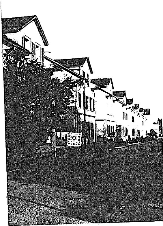
Abb. 17: Stickerhäuschen entlang der Säntisstrasse
