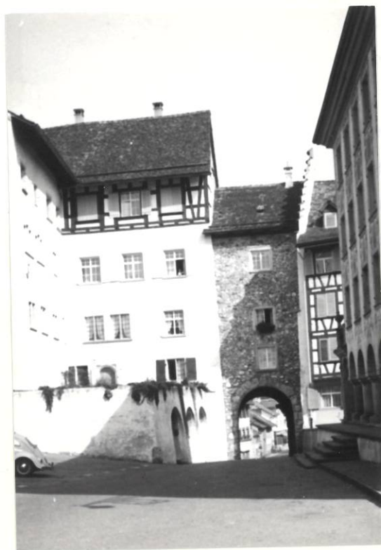
Abb. 7: Tor zur Toggenburg mit Hof (links im Bild) und Baronenhaus (rechts)
