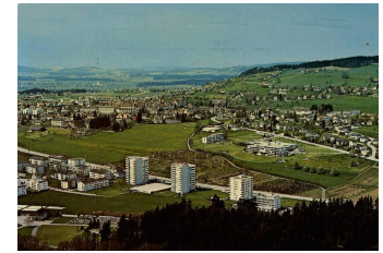
St.Gallerstrasse / Spital um 1975
