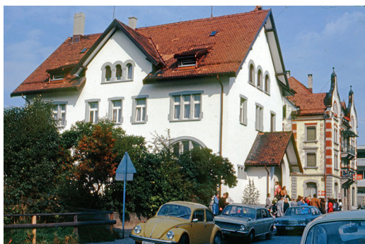
Kapelle Wil nach der Renovation 1975.
