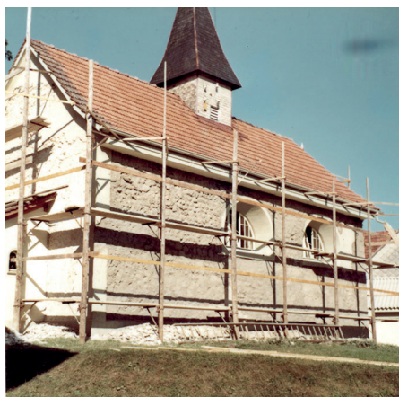
Kapelle Tuttwil während der Renovation 1970/1971
