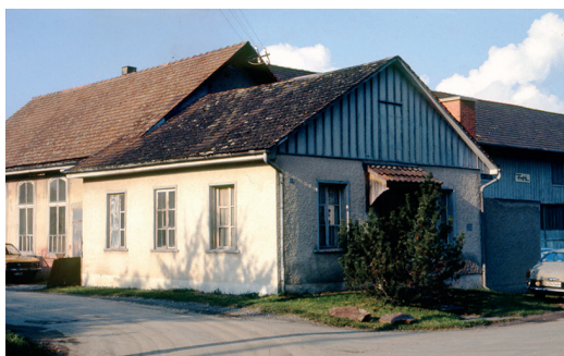
Stickereibetrieb von Konrad Bürgi im Münchwiler Ortsteil Mezikon. Im vorderen Gebäude standen ursprünglich sogenannte Handstickmaschinen. 1898–1953 diente es als Versammlungsraum der FEG.
