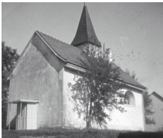
Kapelle in Obertuttwil vor der Renovation von 1970/1971.
