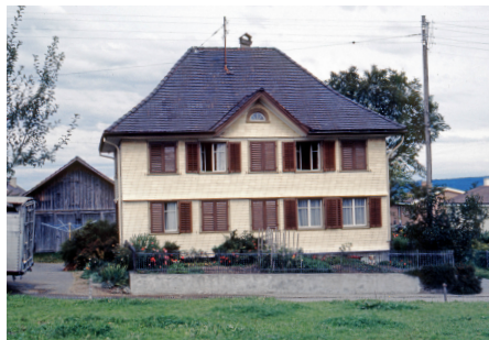
Haus der Familie Stutz in Obertuttwil. Hier bestand ab 1874 ein Betsaal, der für Bibelstunden und die Sonntagsschule genutzt wurde. Gottesdienste fanden in der benachbarten Kapelle statt.
