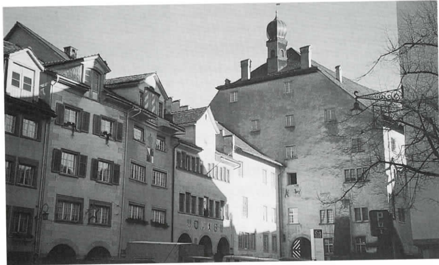
Wiler Hof: Als Freunde des Hofes setzen sich die SD auch für die Restaurierung dieses ehrwürdigen Gebäudes ein. Damit der Hof auch in Zukunft als geschichtsträchtiges Wahrzeichen erhalten bleibt.
