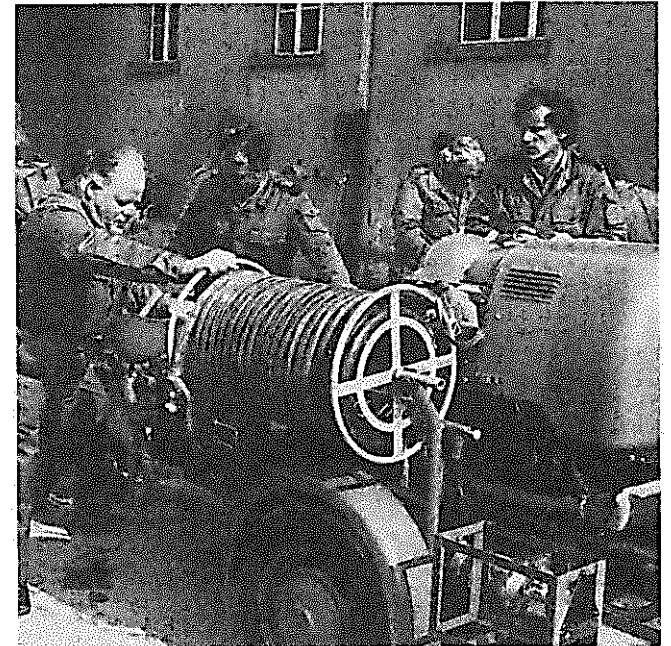
Bau eines Ortskommando- und Sanitätspostens im Lindenhof (Politische Gemeinde)
