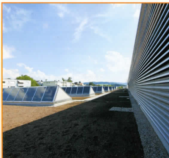
Detailansicht Technikzentrale und Dachlandschaft
