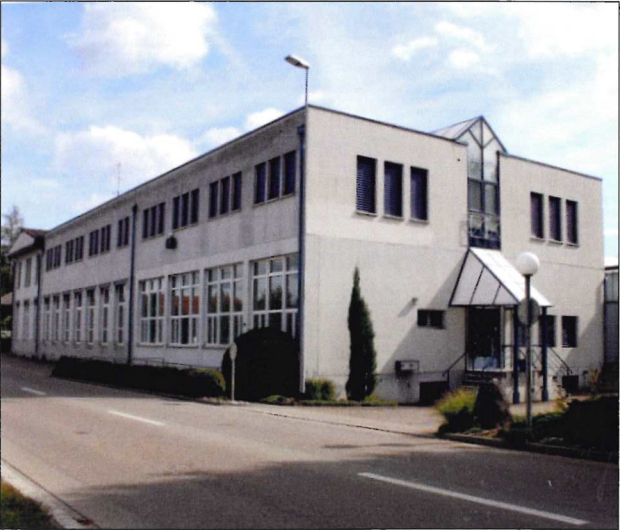
Das 1980 neu erbaute Fabrikgebäude, wie es im Verkaufsprospekt 2019 angeboten wurde. Foto: Montana Treuhand, Chur.
