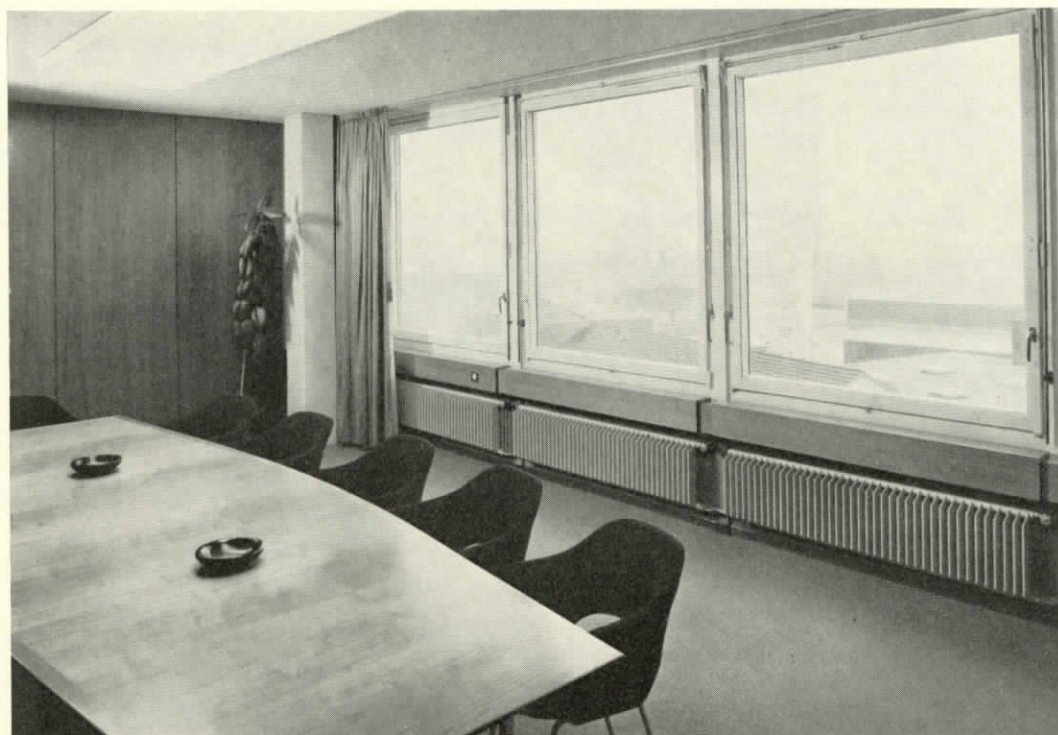
TACO AG, GLATTBRUGG (ZH). Konferenzsaal — Durch die genaue Anpassung der Radiatoren-Länge an die Länge der entsprechenden Fenster ergibt sich ein ruhiges Bild, welches im übrigen harmonisch durch die Verkleidung der Elektrizitäts- und Telefonleitungen ergänzt wird. Das Zusammenwirken von Strahlung und Konvektion der Radiatoren gewährleistet einen angenehmen und gleichmässigen Heizeffekt. Architekt: Carl Rathgeb, dipl. Arch. ETH/SIA, Zürich. Installateur: Hälg & Co., Zürich.
