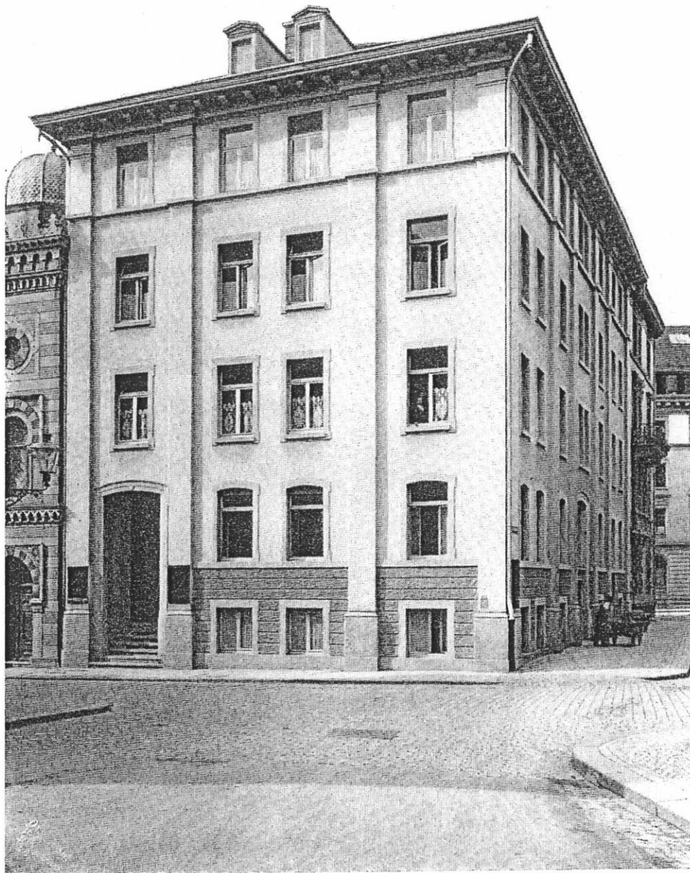
Haus an der Frohngartenstrasse 1885—1888
