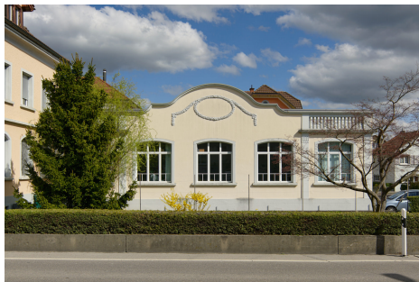
Wohnhaus und Stickereifabriktrakt.
