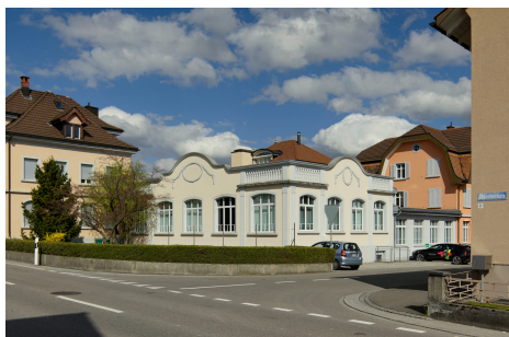
Fabriktrakt mit Vorgarten.
