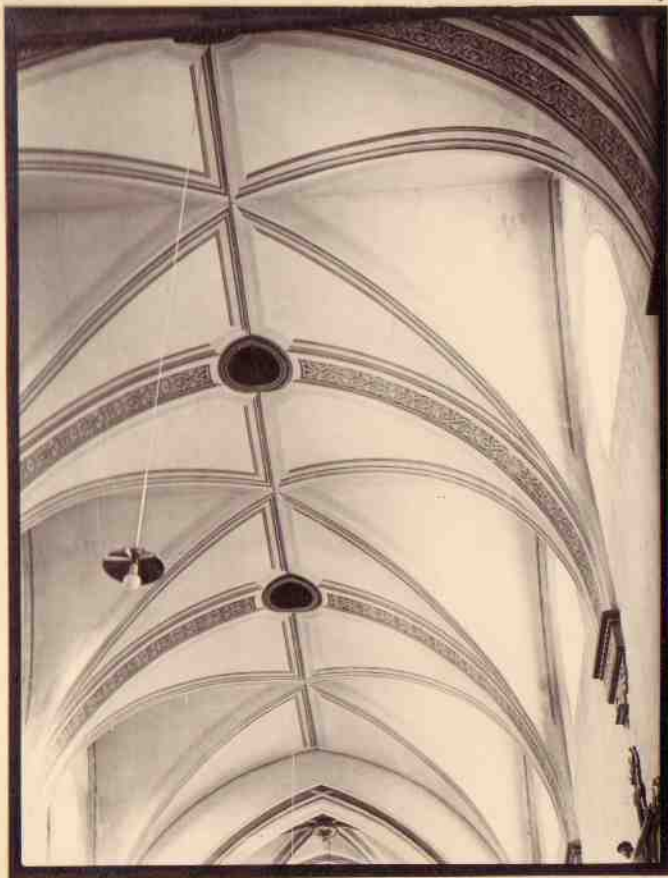
Das alte Gewölbe des Hauptschiffs. (Gips.)
