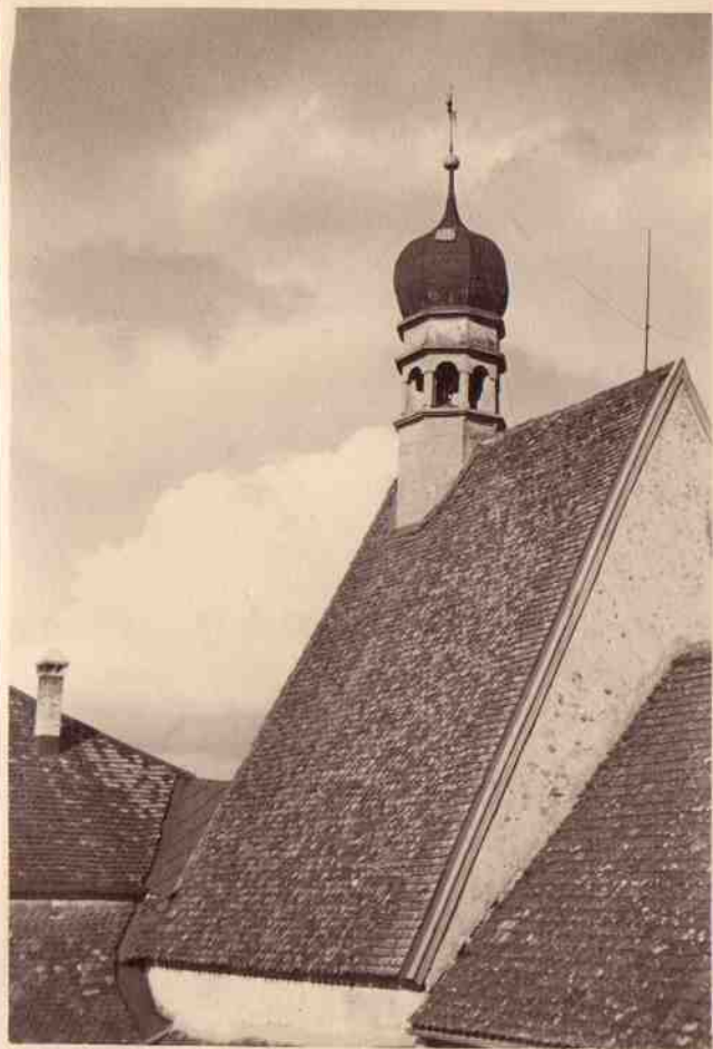
Chordach 3-Türmchen vor der Renovation.
