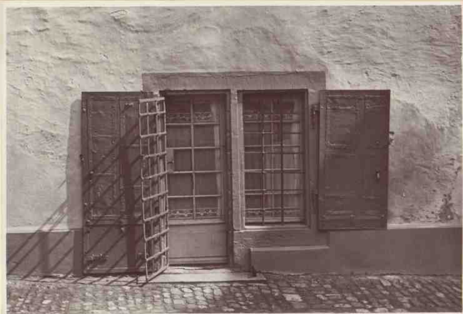
Der alte Eingang zur Sakristei. [Letztere jetzt Taufkapelle.]
