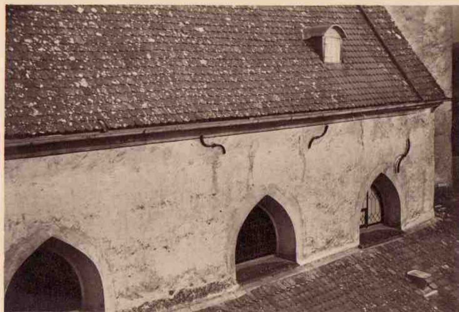
Aussenmauer d. Hauptschiffs, nordseits, vor der Renovation.
