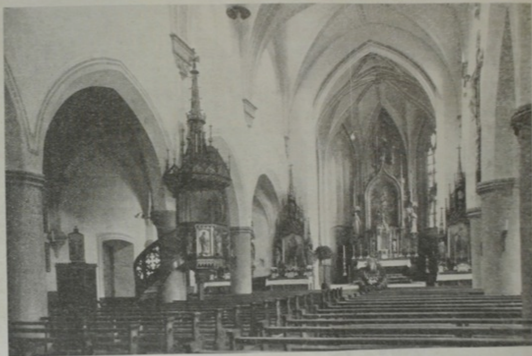
INNENANSICHT VOR DEM UMBAU
