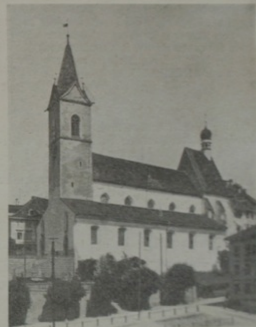
PFARRKIRCHE ST. NIKOLAUS VOR DEM UMBAU
