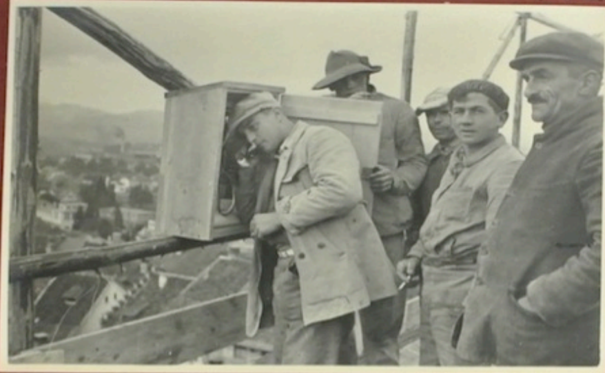
Am Telefon auf dem 12. Gerüststock, Höhe Wachtstube.
