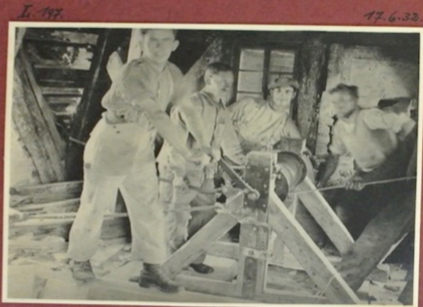
Auch der Glockenstuhl muss weichen, Schwere Balken, alle eichen; Zimmerleut' mit Kraft und Eile Lassen sie hinab am Seile.
