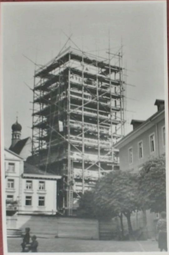
Das 12. [- letzte volle] Gerüststockwerk ist erstellt.
