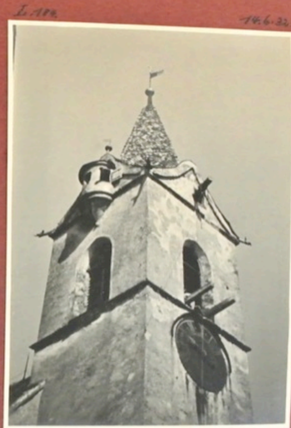
Der Turm mit den hohlen Schallöffnungen
