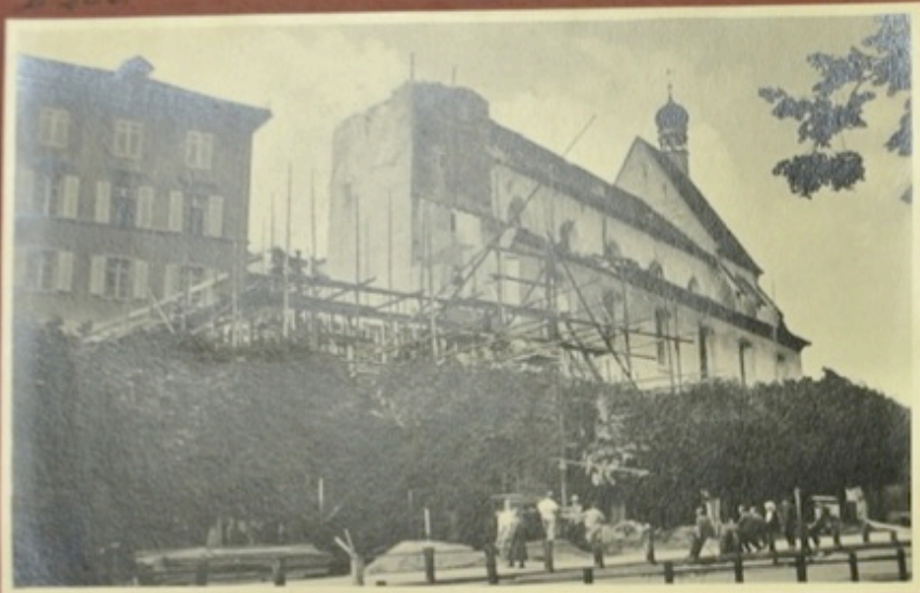
Das Gerüst für den Terrassenbau in voller Höhe.
