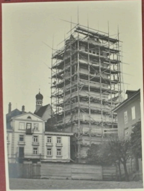
Das „Interregnum“ auf dem Turm: Der Mauer ist fertig; der Zimmermann soll kommen.
