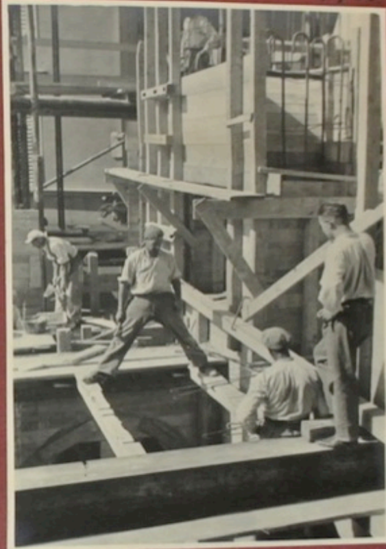
I. Empore & Schalung St. Turm.
