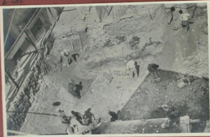
Die Turm-Fundament Grube: Bald fertig.
