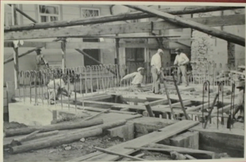
Der neue Turm, entschalt, auf Endbodenhöhe.
