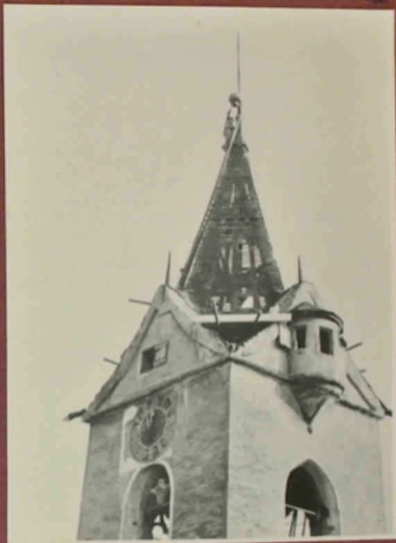
Die Kugel wird mit Flaschenzug hochgehoben.
