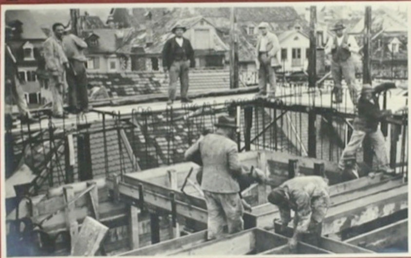
Arbeit am II. Stock des Turmgerüsts, an der Schalung für die Decke des III. Stockes (Kirchenstiege)
