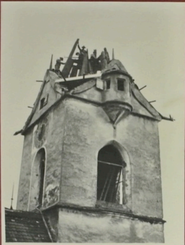
Der nahezu abgebrochene Helm.
