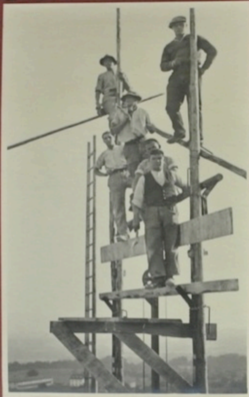
Vorwiegend auf dem höchsten Stangen des Gerüsts, 30 m Höhe.
