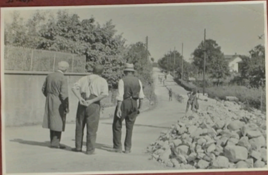
Schutt vom Abbruch dient zum Auffüllen der Fürstentumstrasse
