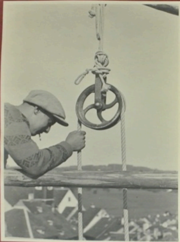
Transport auf dem 12. Gerüststock.
