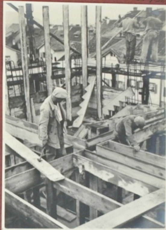
Arbeit am II. Stock des Turmgerüsts, an der Schalung für die Decke des III. Stockes (Kirchenstiege)
