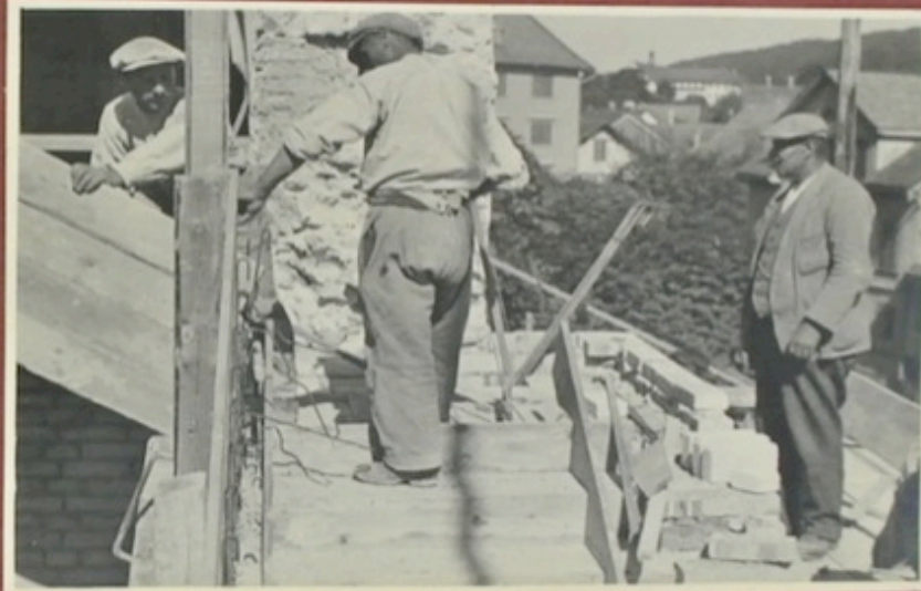
Die Emporenstiege mänerscits wird geschalt.
