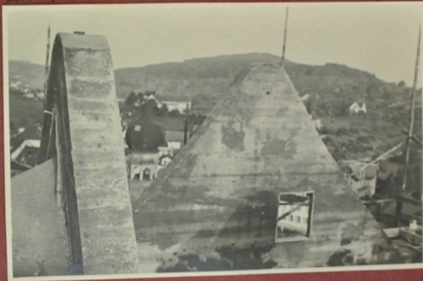
Die ausgeschaltten Wimperge [Nord & Ost]
