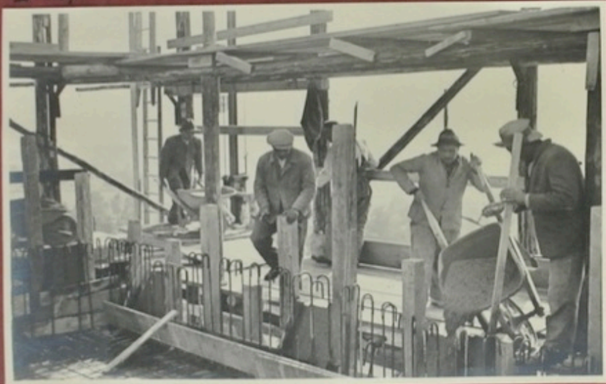
Auf dem 8. Gerüststock: Betonieren des Bodens der Uhrenstube.
