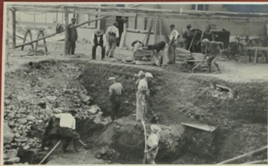
Die Turm-Fundament-Grube gg. d. alten Turm.
