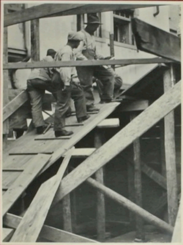
Schalung für die Treppe, die gleich- zeitig mit dem Turm betoniert wird.
