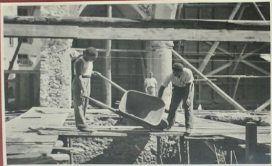
Die Betonierung des Turmfundaments beginnt.
