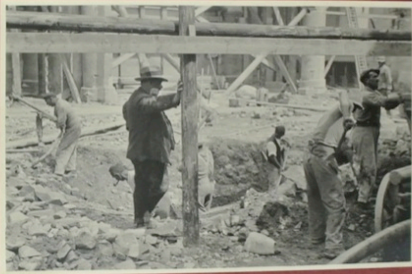
Beginn des Auskubs der Turm-Fundament- Grube.
