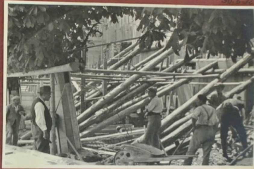
Die Baustelle für Markthallen, Terrassen-Stützmauer mit den schweren Vorpressungen.
