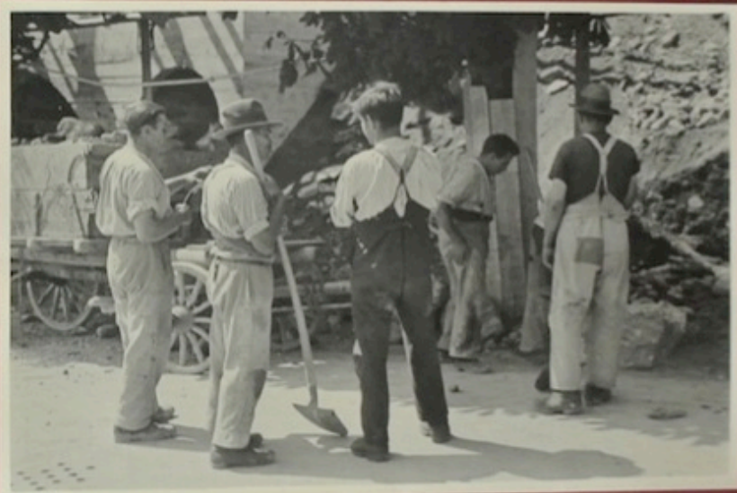
Schutt vom Heizraum Aushub. Verlad an der Grabenstrasse.
