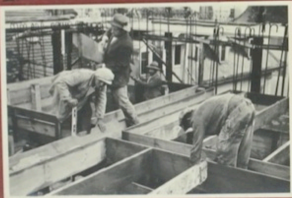
Schalarbeit für Decke des M. Turmstockes.
