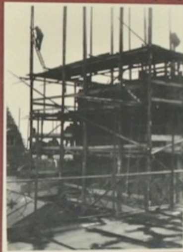
Ein Frechdach auf wichtiger Leiter / VI. Gerüststock.
