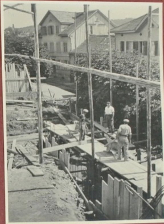
Die Stützmauer d. Kirchentreppe.
