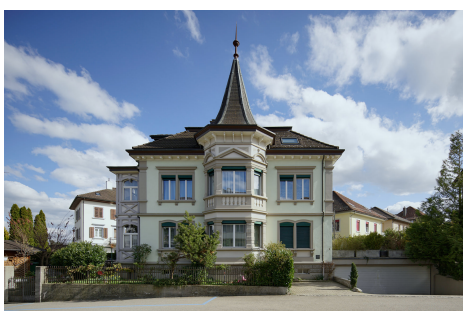
Fassade gegen die Hörnlistrasse.
