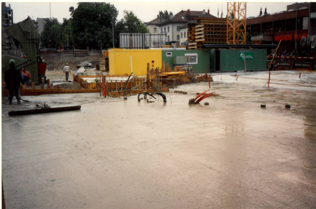
D e c k e für Personen-Unterführung + Shop-Center 4. August 1992
