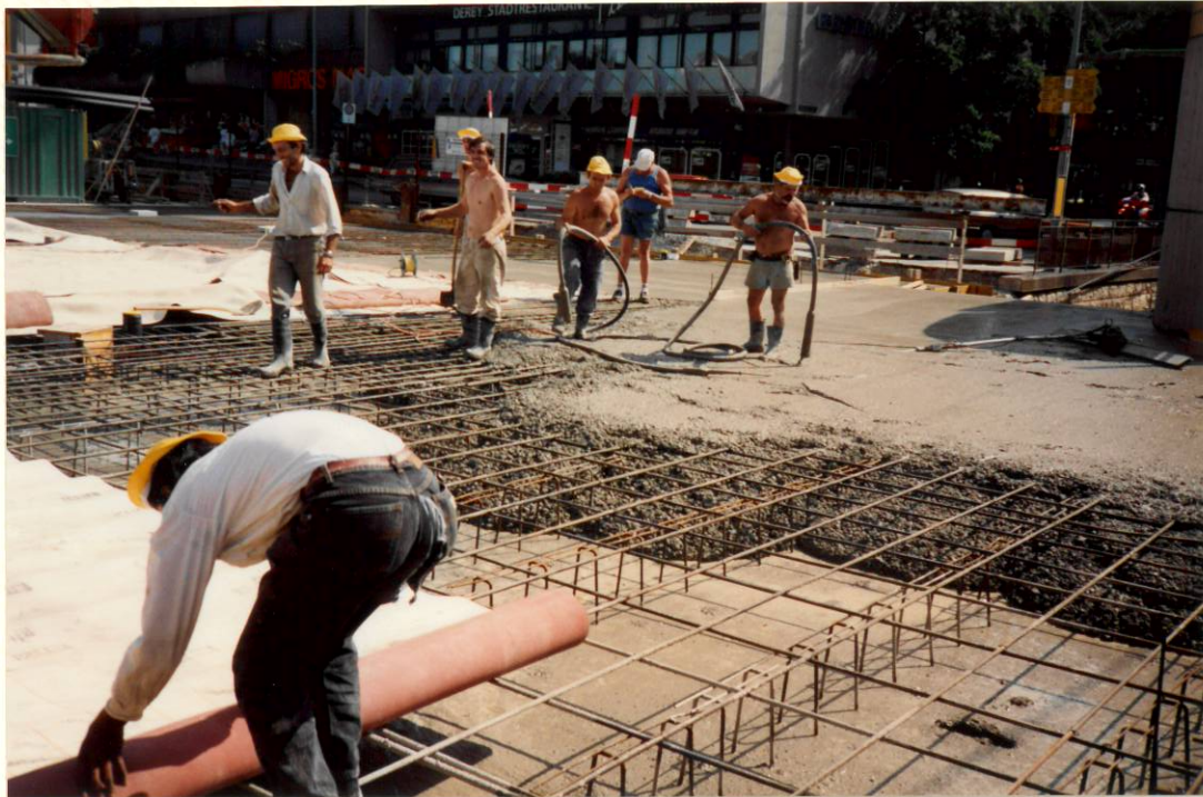
D e c k e für Personen-Unterführung + Shop-Center 3. August 1992
