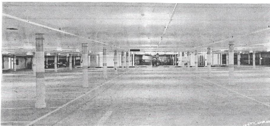
Mit der Eröffnung des zweiten Teils des Parkhauses am Bahnhofplatz stehen 429 Parkplätze zur Verfügung.
