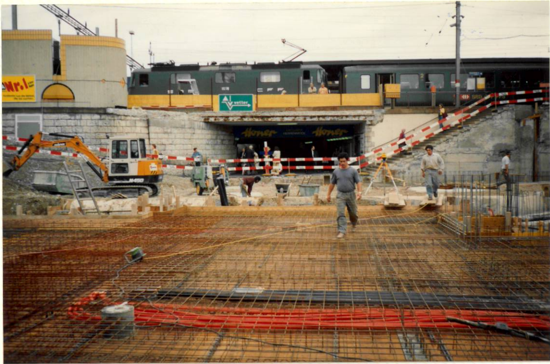
Schalung B o d e n für Personen-Unterführung + Shop-Center 5. Juni 1992
