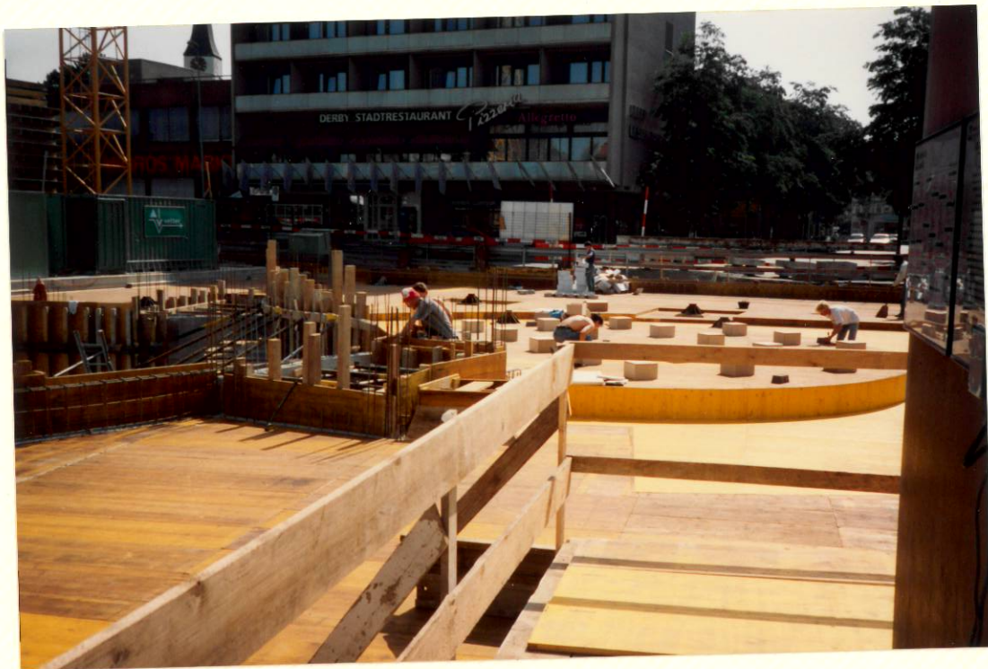
Schalung D e c k e Personen-Unterführung + Shop-Center 20. Juli 1992
