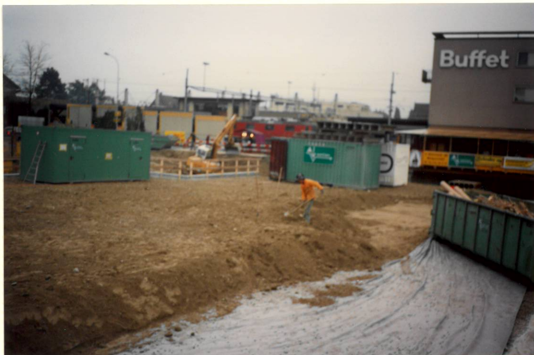
Auffüllung mit Aushub 2. Etappe 4. Dezember 1991
