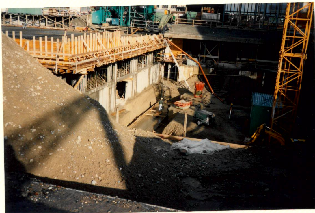
Baugrube für Personen-Unterführung 19. November 1991
