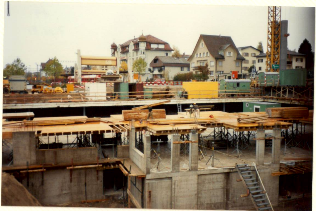
Schalung D e c k e für 1. Untergeschoss 2. Teil 7. November 1991
