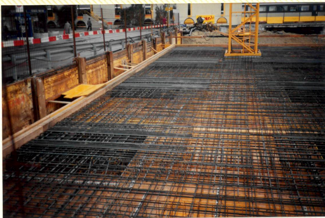
Schalung D e c k e 1. Untergeschoss Personen-Unterführung + Shop-Center 12. März 1992
