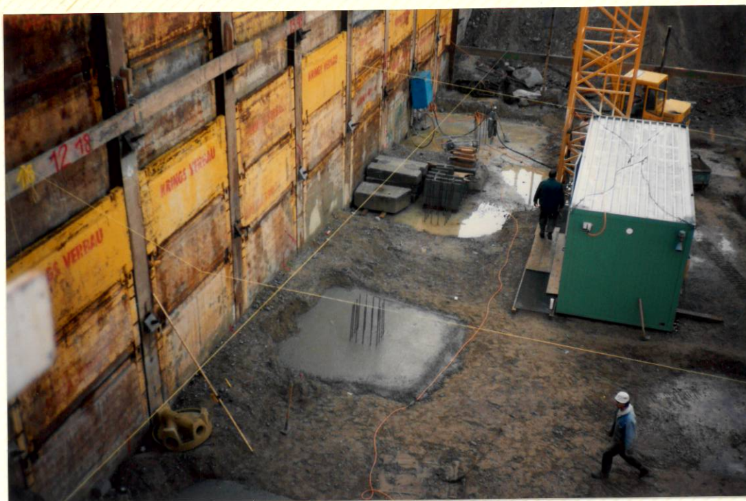
Sockel für die Decke Personen-Unterführung + Shop - Center 19. November 1991
