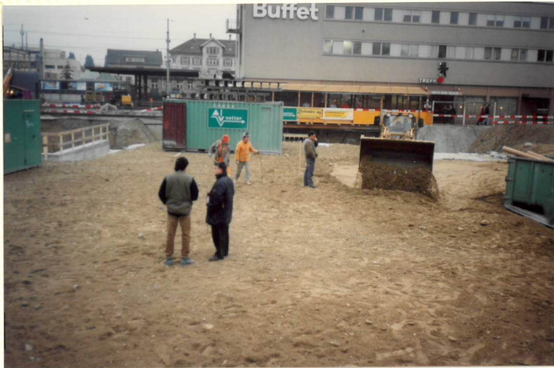
Auffüllung mit Aushub 2. Etappe 19. November 1991
