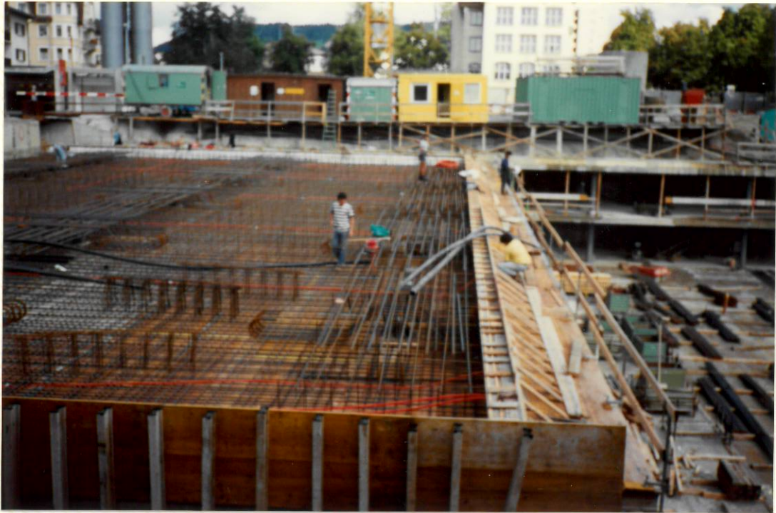
Schalung Decke für 1. Untergeschoss 1. Oktober 1991
