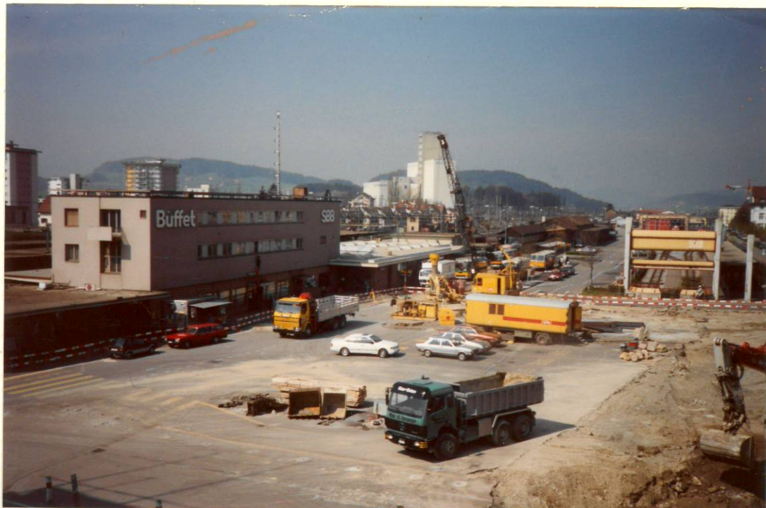
Aushub Bahnhofplatz 2. Etappe 26. April 1991
