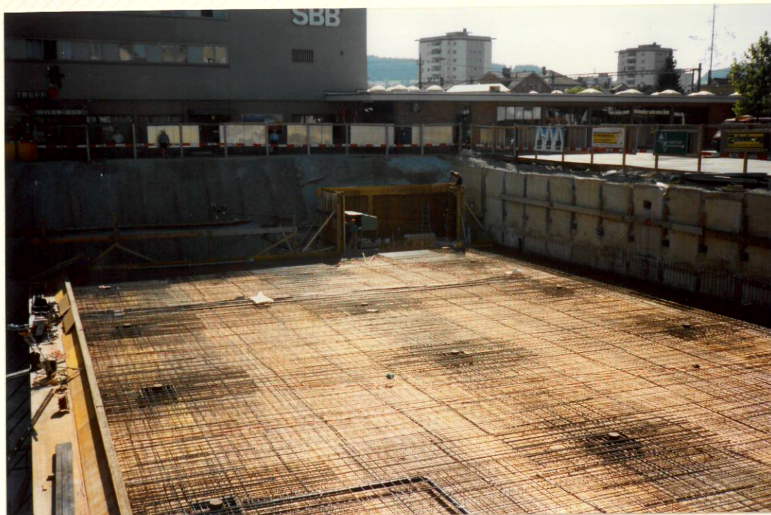
Schalung D e c k e für 2. Untergeschoss 9. September 1991
