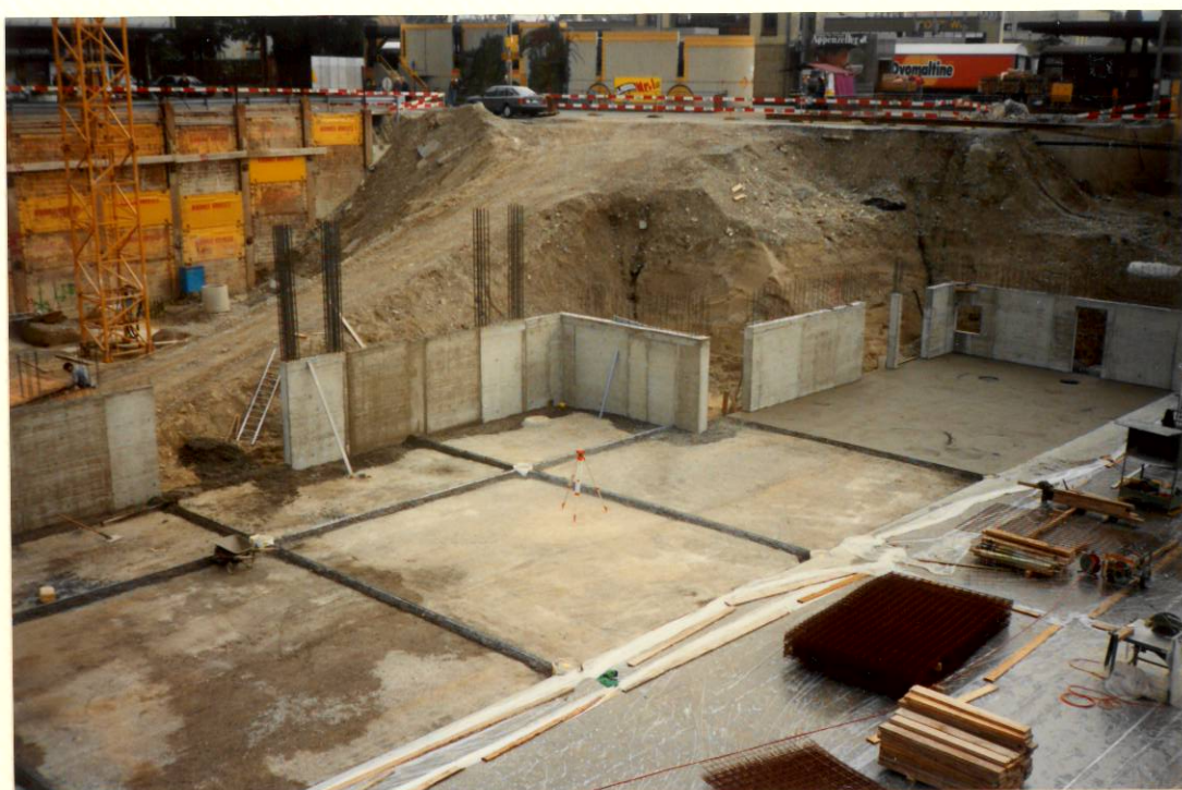
B o d e n für das 2. Untergeschoss 2. Teil 11. Oktober 1991
