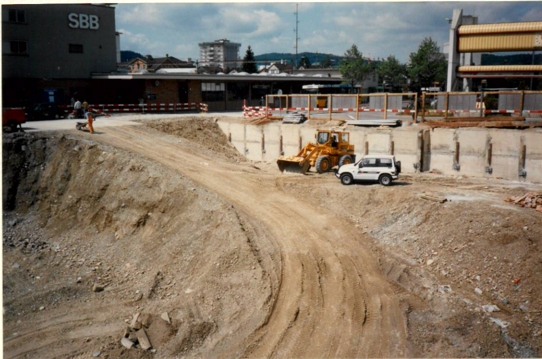
Aushub Bahnhofplatz 2. Etappe 11. Juni 1991
