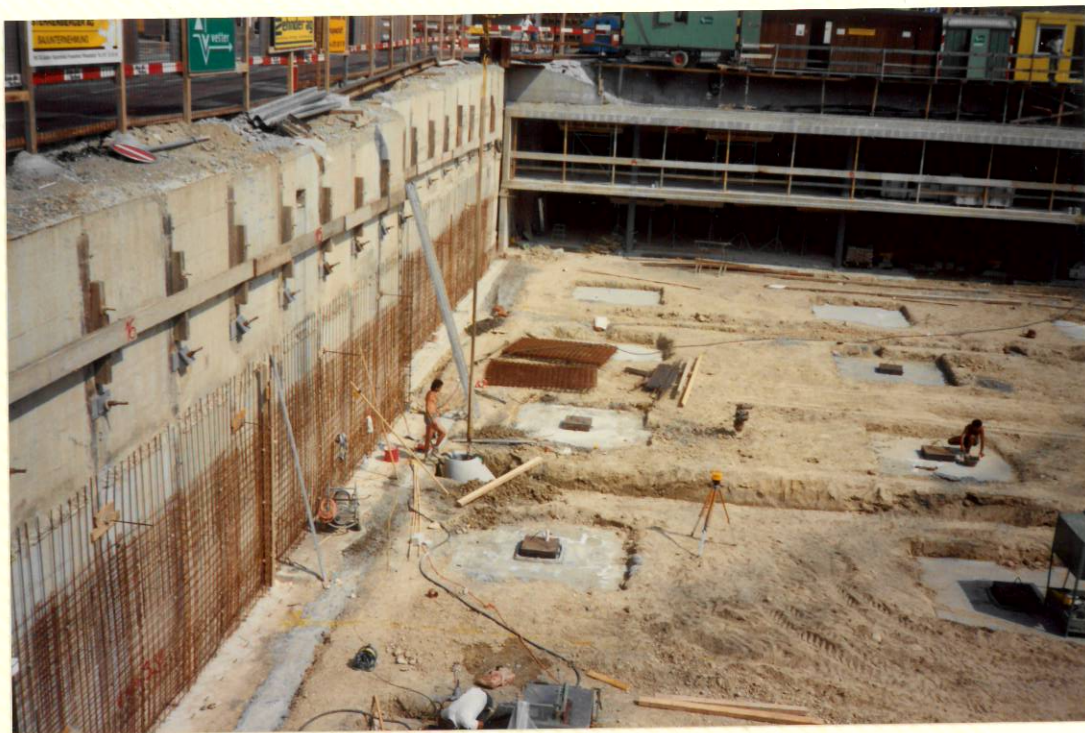
Sockel für die Träger der Decke 16. August 1991
