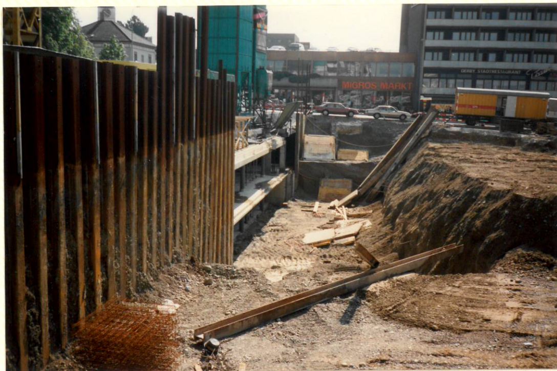
Aushub Bahnhofplatz 2. Etappe 31. Mai 1991
