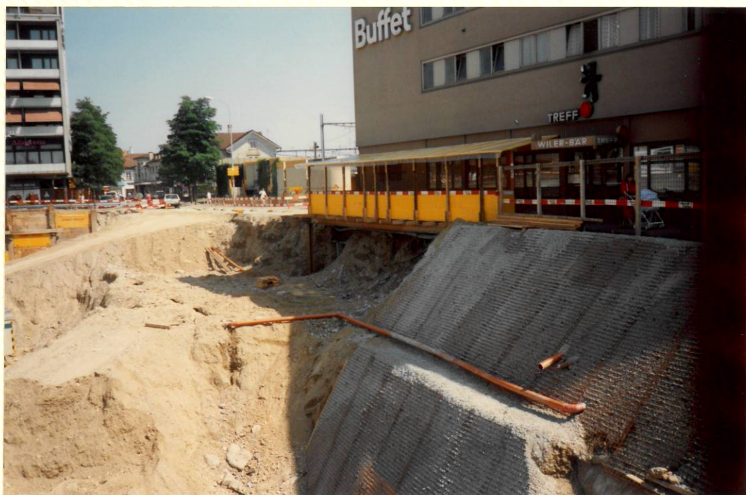
Aushub Bahnhofplatz 2. Etappe 23. Juli 1991
