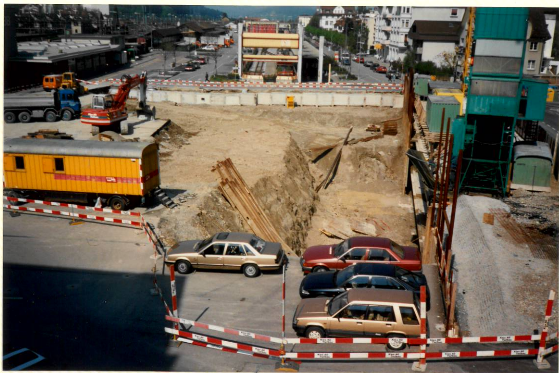
Aushub Bahnhofplatz 2. Etappe 14. Mai 1991
