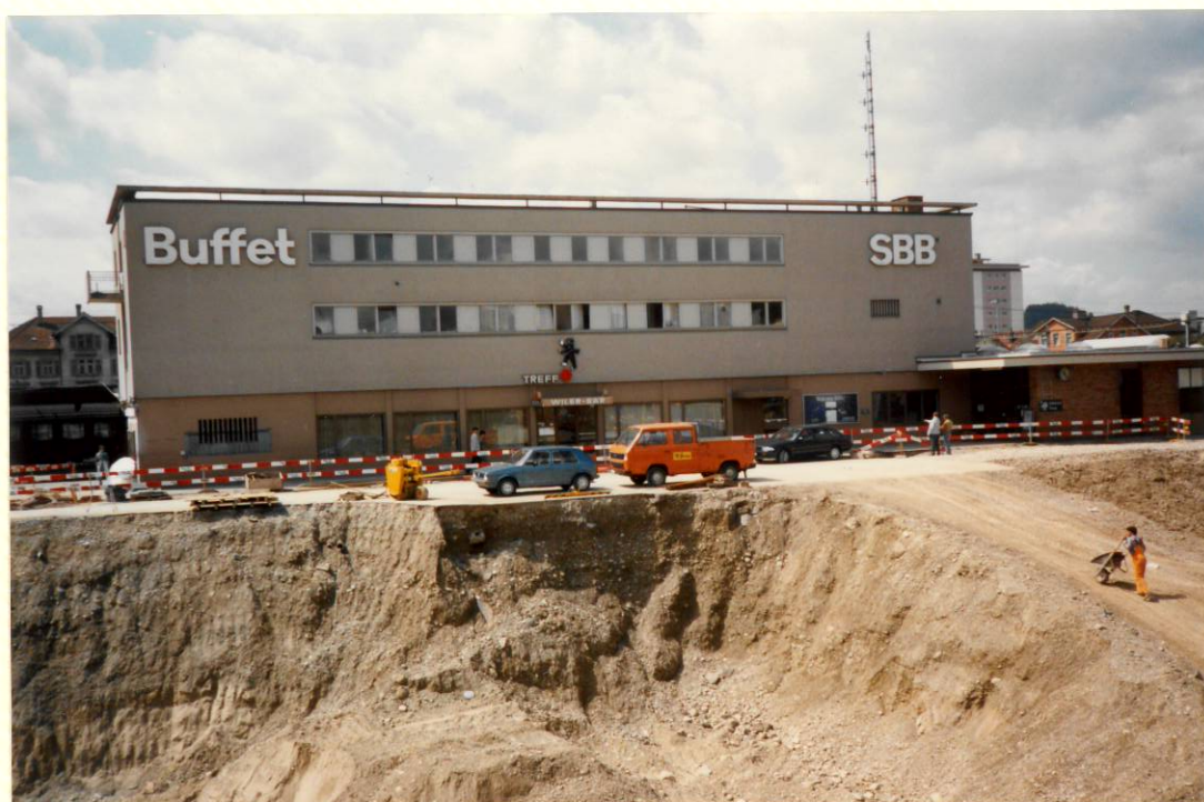
Aushub Bahnhofplatz 2. Etappe 11. Juni 1991
