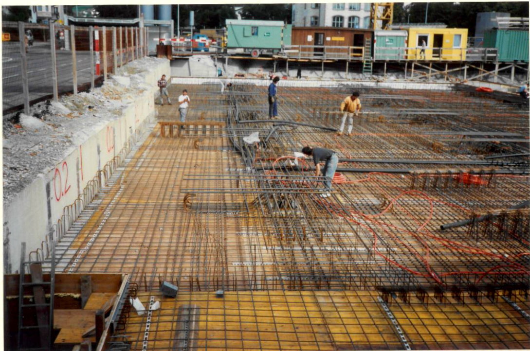
Schalung D e c k e für 1. Untergeschoss 1.10ktober 1991
