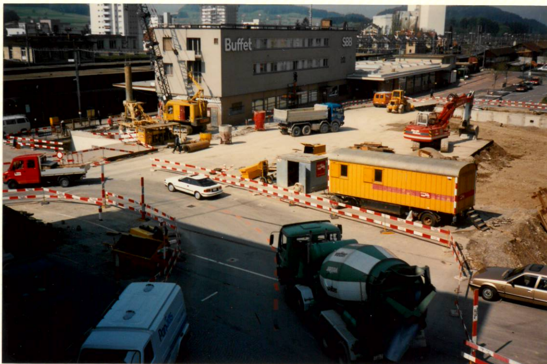
Bahnhofgebäude nach Abbruch des Kiosk 14. Mai 1991
