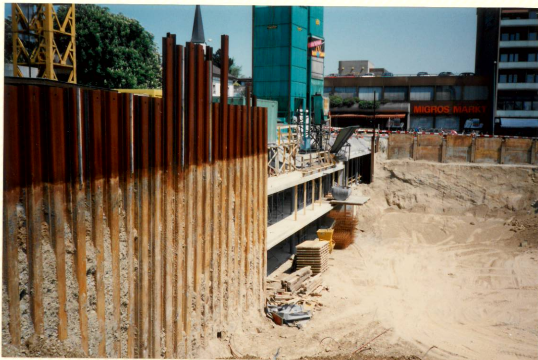
Aushub Bahnhofplatz 2. Etappe 14. Mai 1991
