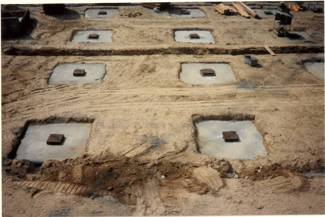
Sockel für die Träger der Decke 16. August 1991
