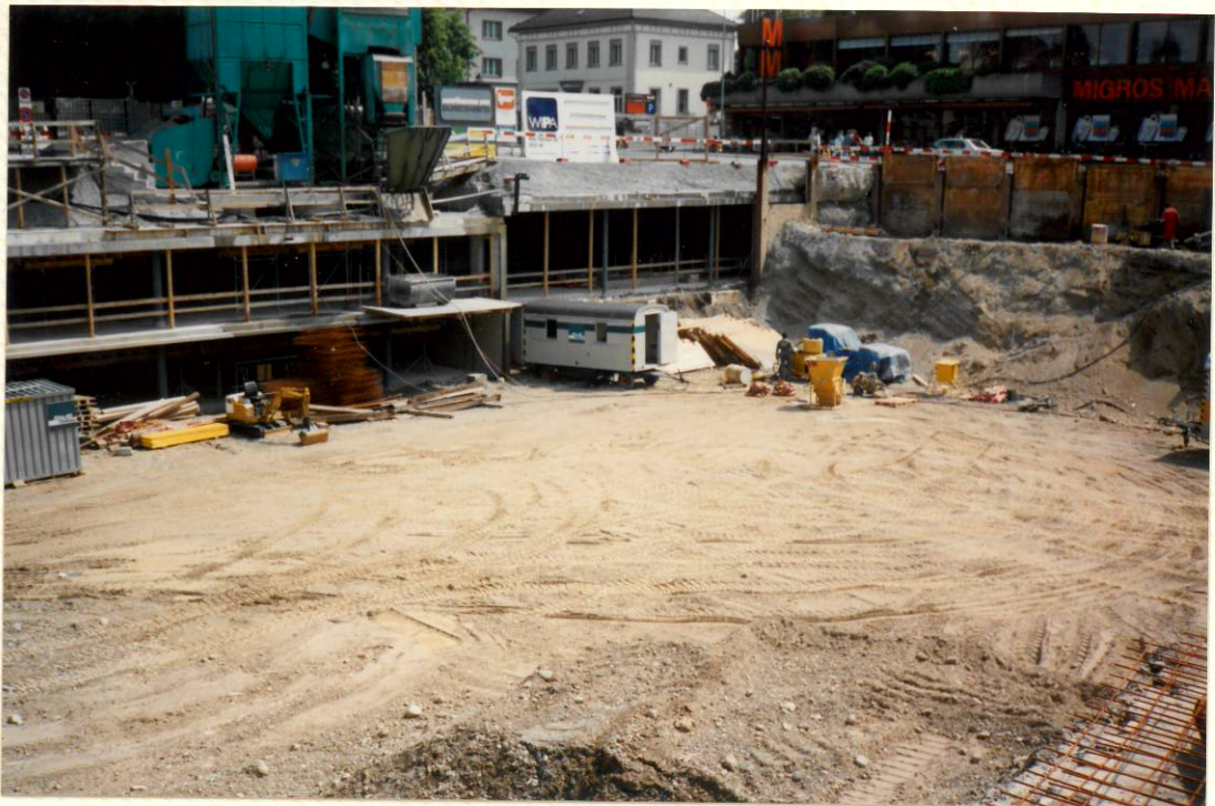
Aushub Bahnhofplatz 2. Etappe 11. Juni 1991
