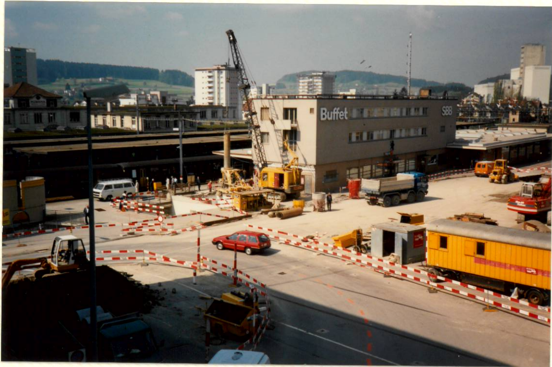
Bahnhofgebäude nach Abbruch des Kiosk 14. Mai 1991
