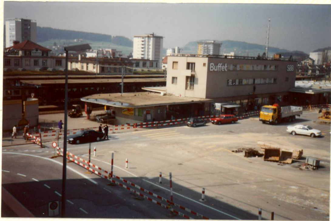
Bahnhofgebäude mit Kiosk 26. April 1991
