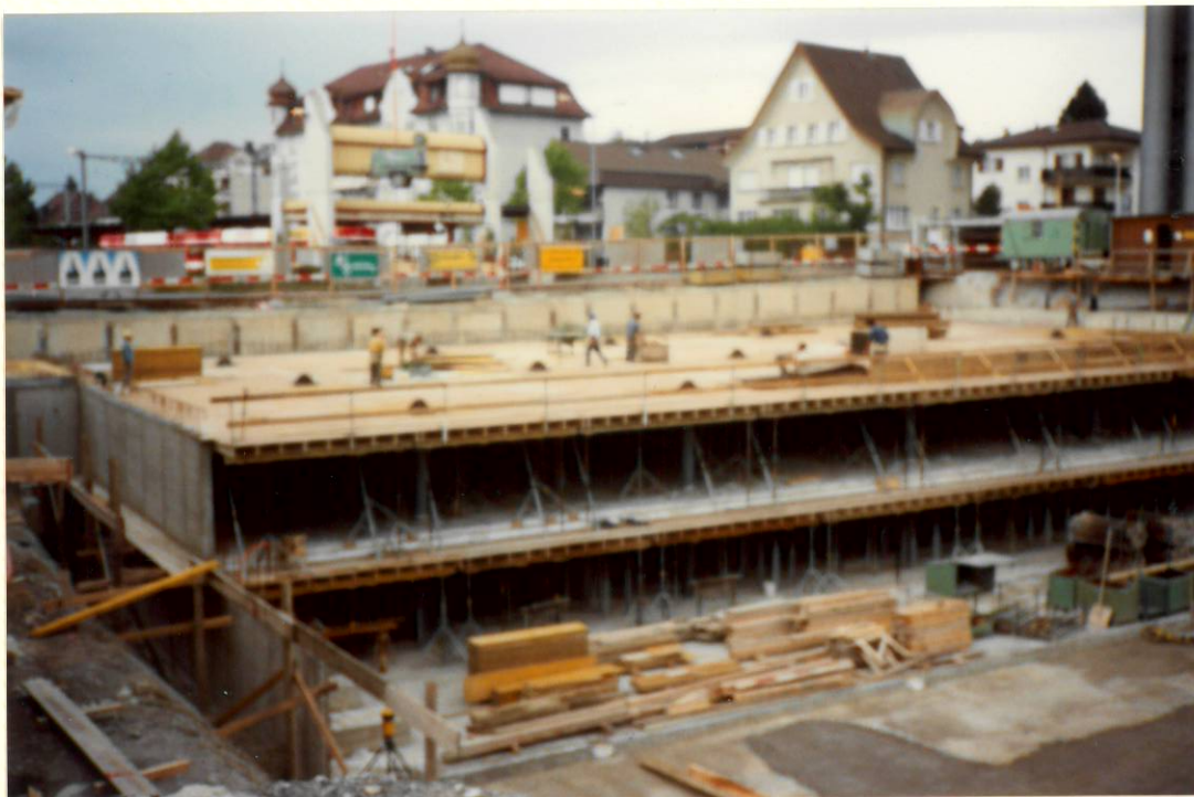
Schalung D e c k e für 1. Untergeschoss 26. September 1991
