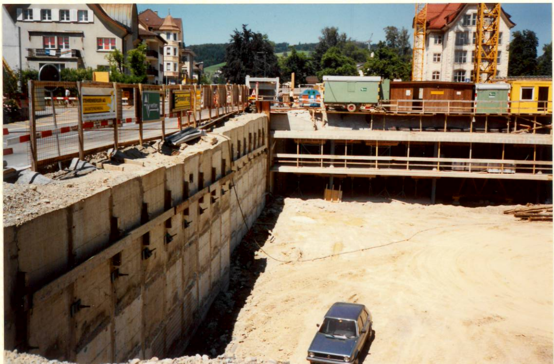
Aushub Bahnhofplatz 2. Etappe 2. Juli 1991
