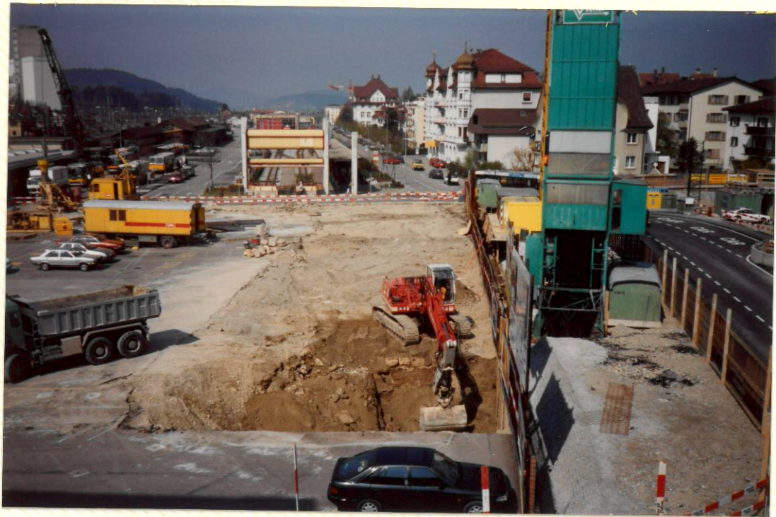
Aushub Bahnhofplatz 2. Etappe 26. April 1991
