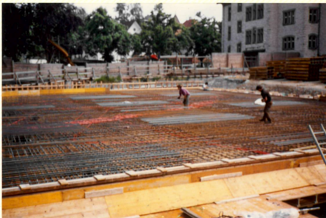
Schalung Decke beim Kreisel 11. Juni 1991
