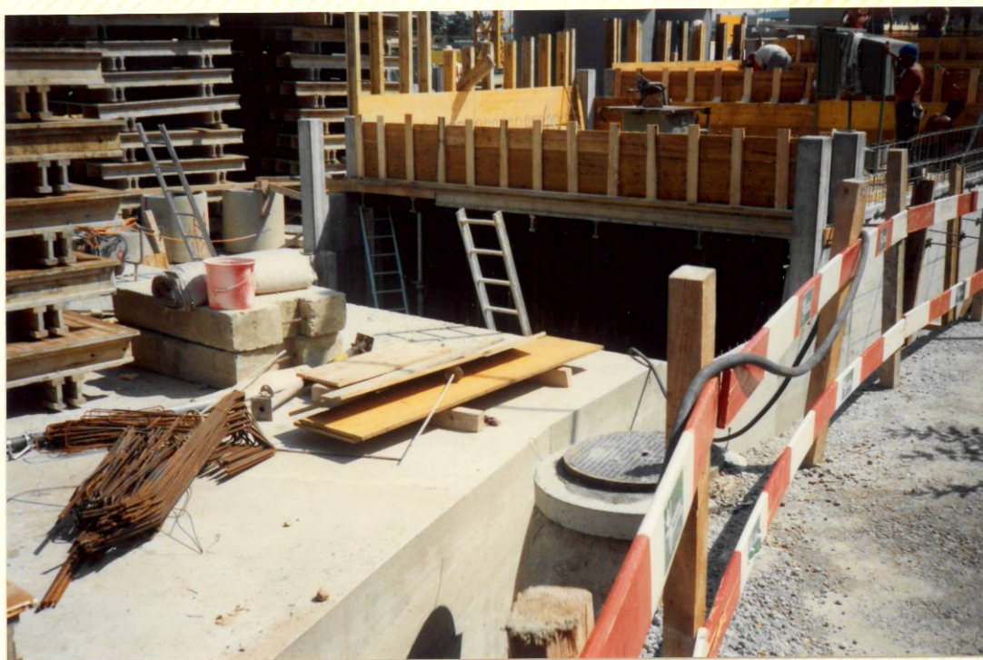
Decke für Einfahrt 23. Juli 1991
