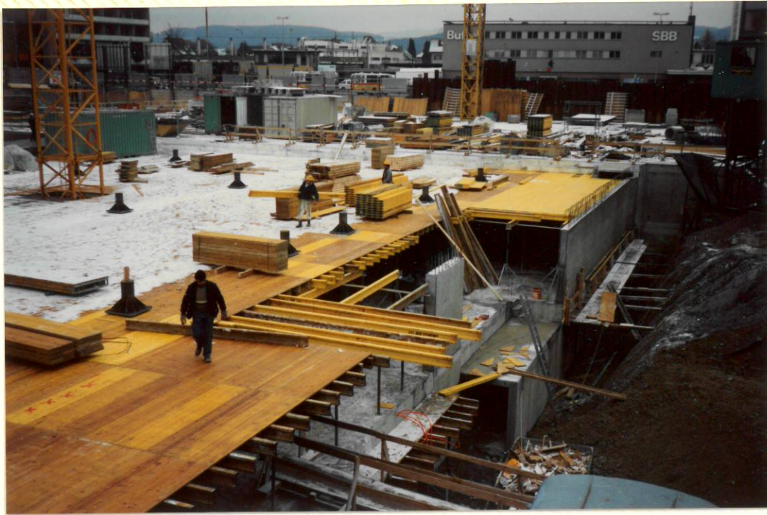
Schalung Decke für 1. Untergeschoss 2. Teil 3. Dezember 1990
