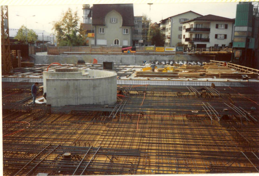
Schalung D e c k e für 1. Untergeschoss 30. Oktober 1990
