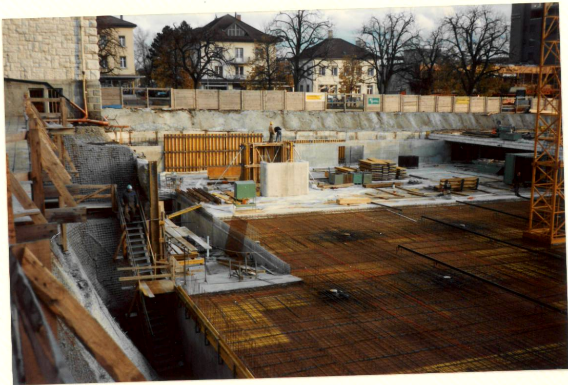
Schalung D e c k e f ü r 2. Untergeschoss 2. Teil 9. November 1990
