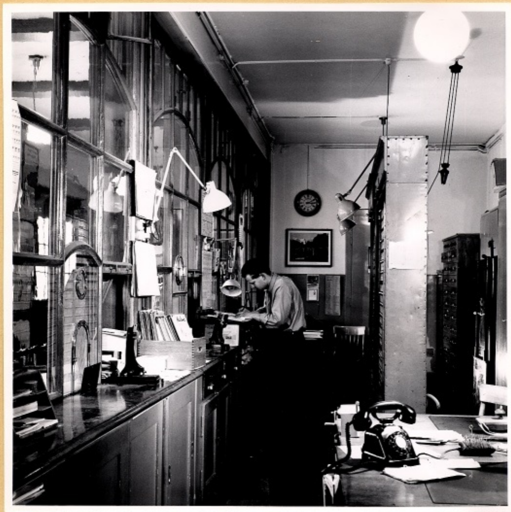
No. 30: Einnehmerei, Schalteranlage
