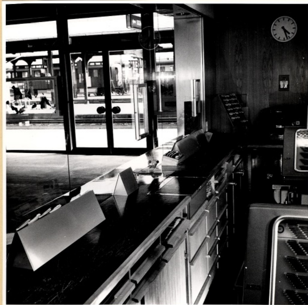
No. 130: Einnehmerei, Schalteranlage, rechts 2 AEG-Billettdrucker, hinter AEG Kleindrucker BZT
