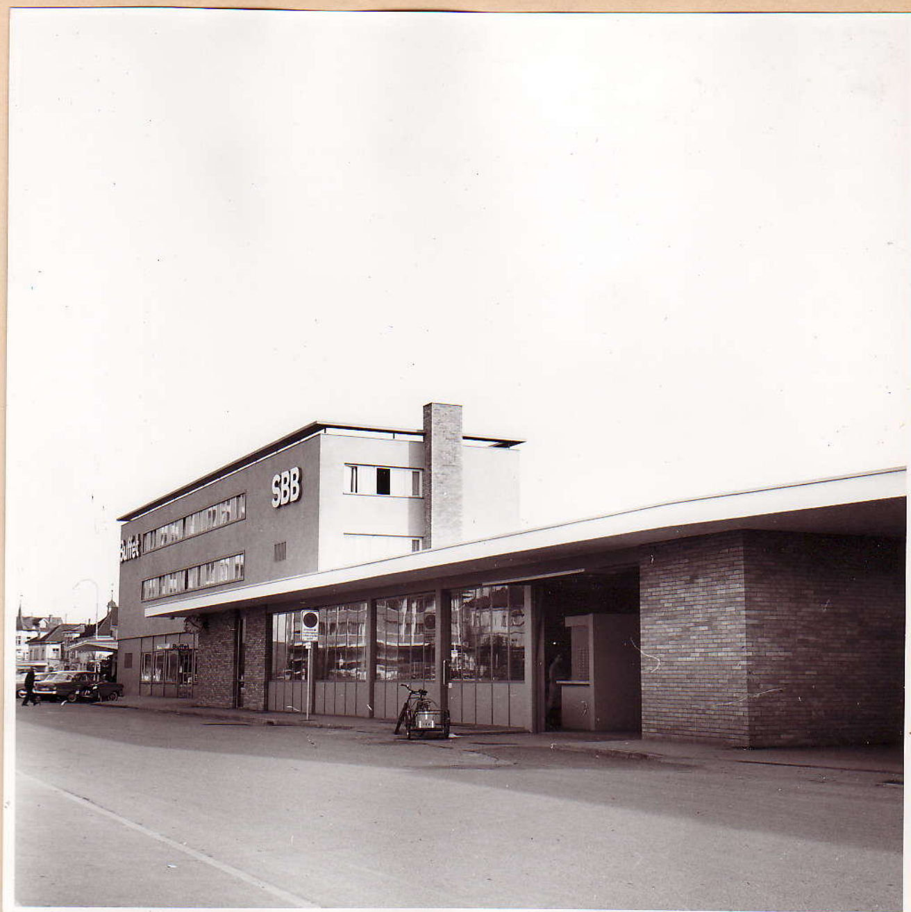
No. 104: Ansicht von NW, Seitentrakt Gepäcklokal, Einfahrt für Lastwagen. Beachten: Empfangsloge bei Tor
