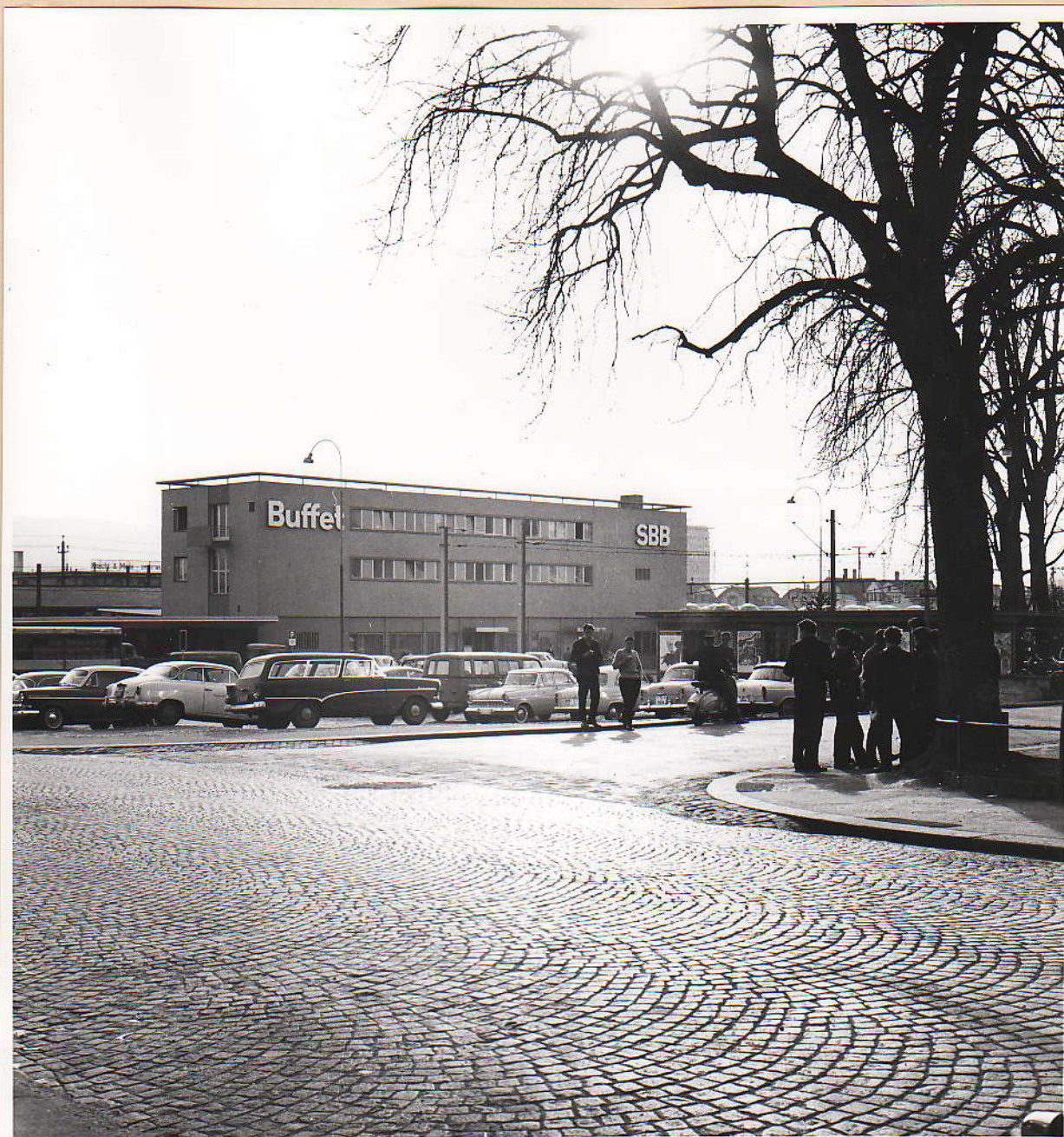
No. 101: Ansicht des neuen Aufnahmegebäudes von der oberen Bahnhofstrasse gesehen. Provisorischer Parkplatz, später Autobushaltestelle.
