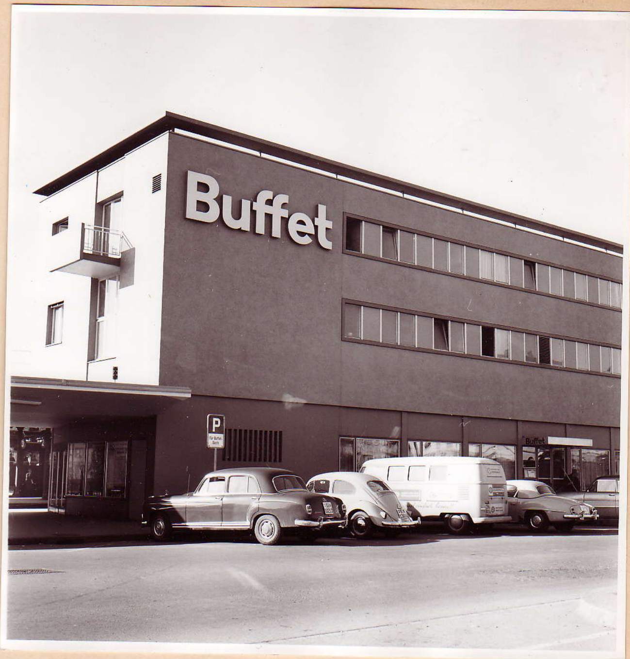
No. 105: Ansicht von NO, Durchgang zum Perron I, Buffettrakt.
