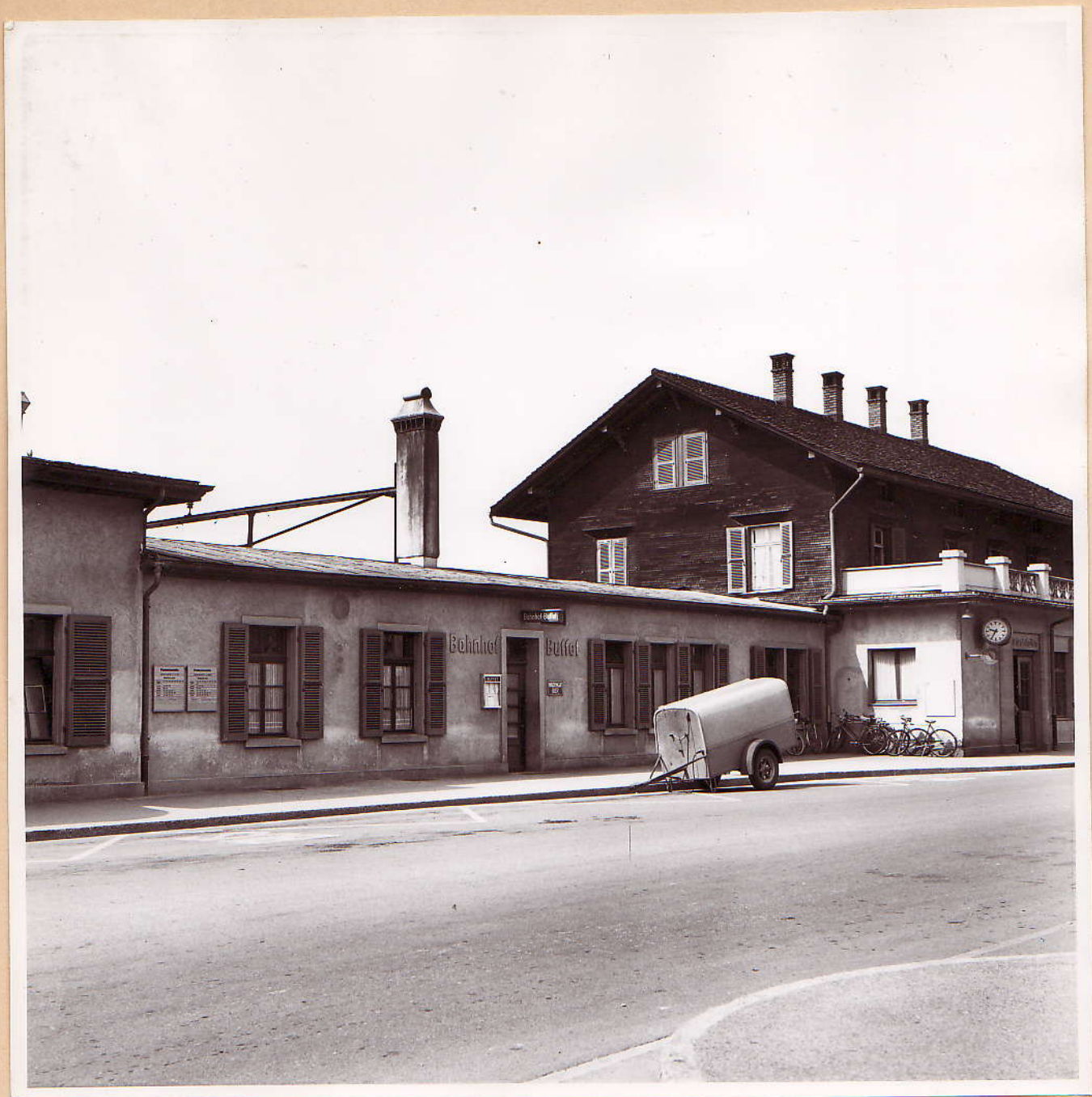
No. 5: Ansicht von NO, Buffettrakt.
