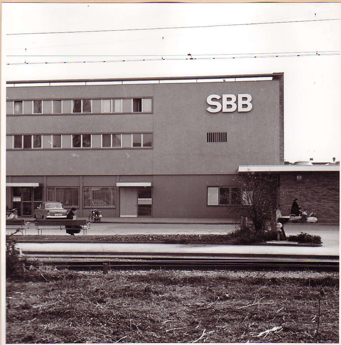
No. 103: Ansicht Strassenseite, Eingänge zu Buffets, Dienstwohnung Dienstwohnungen, Schalterhalle (v.l.n.r.).
