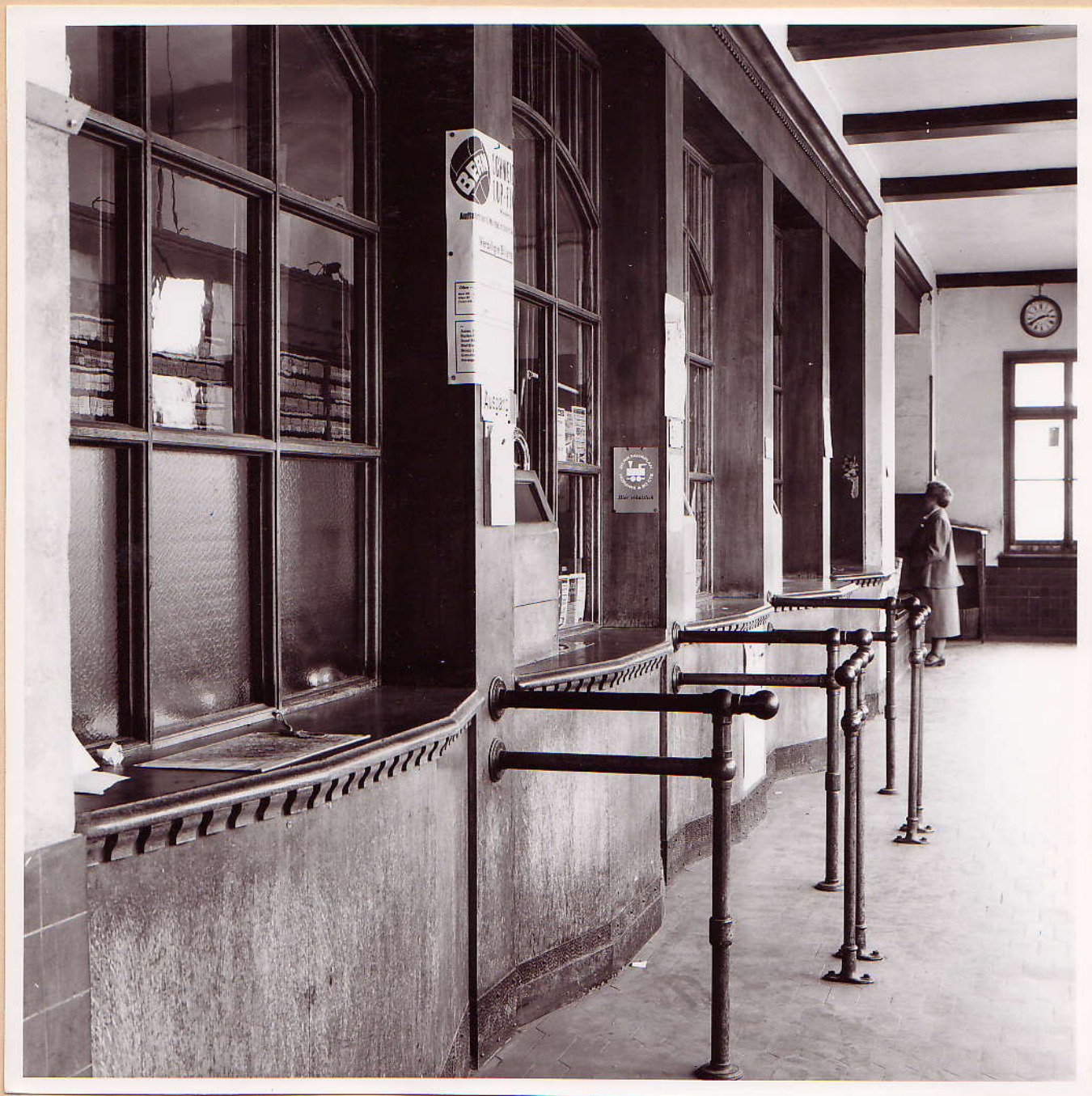
No. 17: Schaltervorhalle, Billetschalter, hinten Gepäckaufgabe
