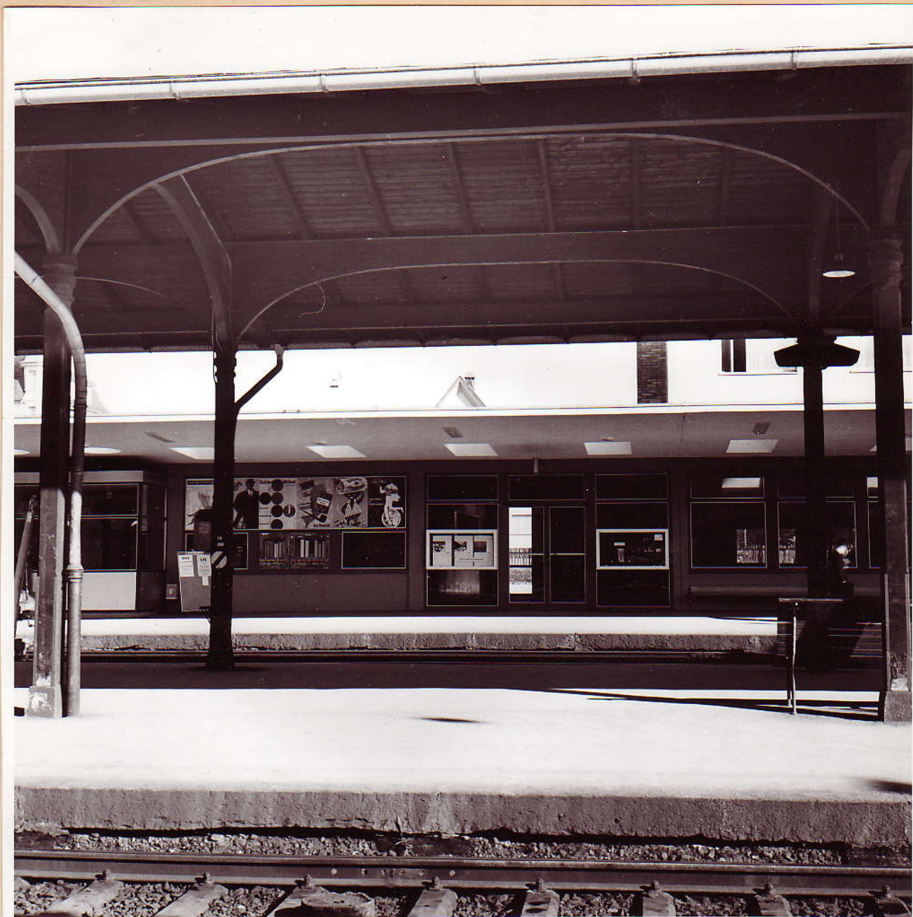
No. 116: Durchsicht vom Perron 3 gegen Gleisfront v.l.n.r.: Fahrdienstkanzel, Eingang zur Schalterhalle, Wartsaal
