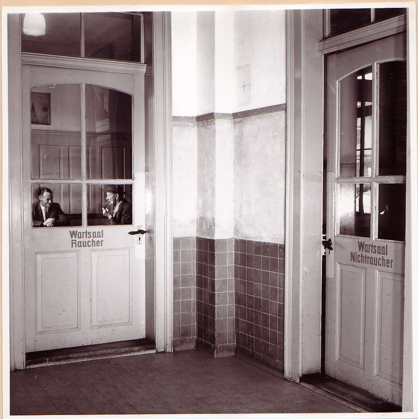
No. 20: Eingänge zu den Warteräumen
