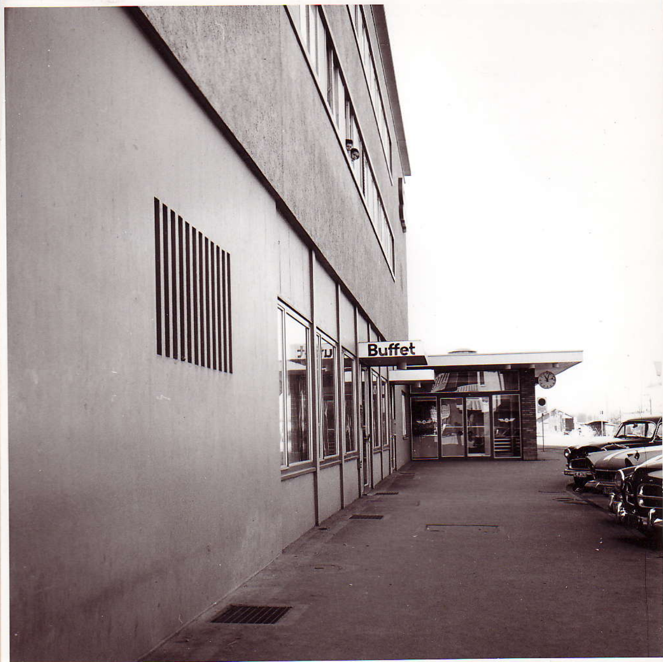
No. 108: Ansicht gegen Eingang zur Schalterhalle.
