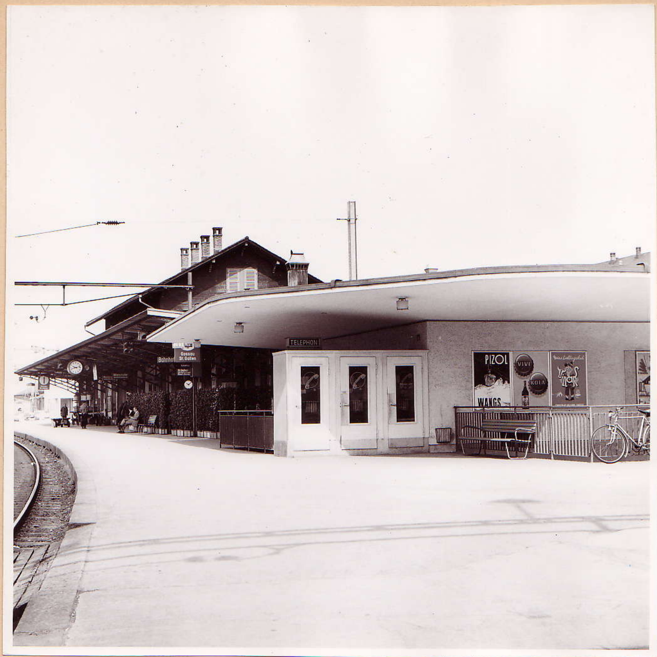
No. 12: Ansicht von SO, Perron 1
