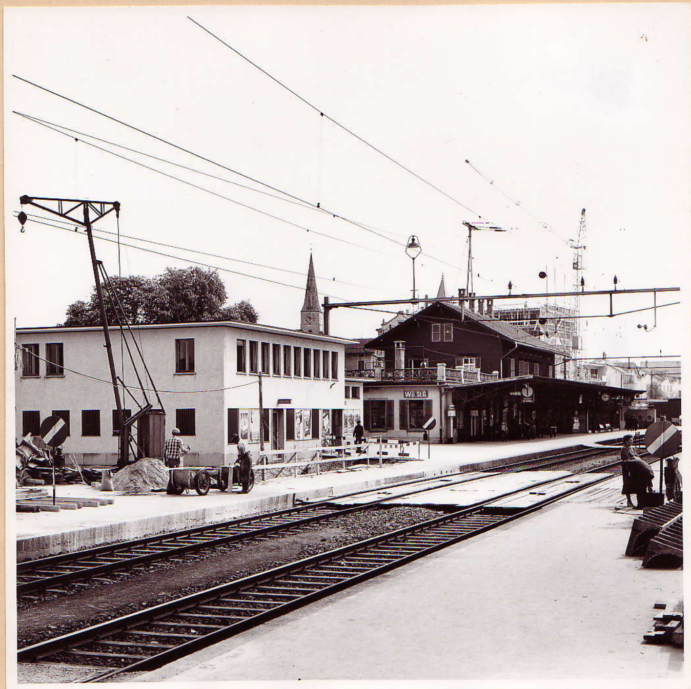
No. 13: Ansicht von W, neue West-Unterführung im Bau
