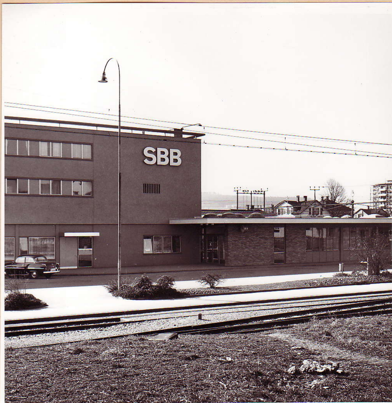
No. 110: Eingang zur Schalterhalle. Beachten: Einfall Tageslicht durch Plexiglaskuppeln
