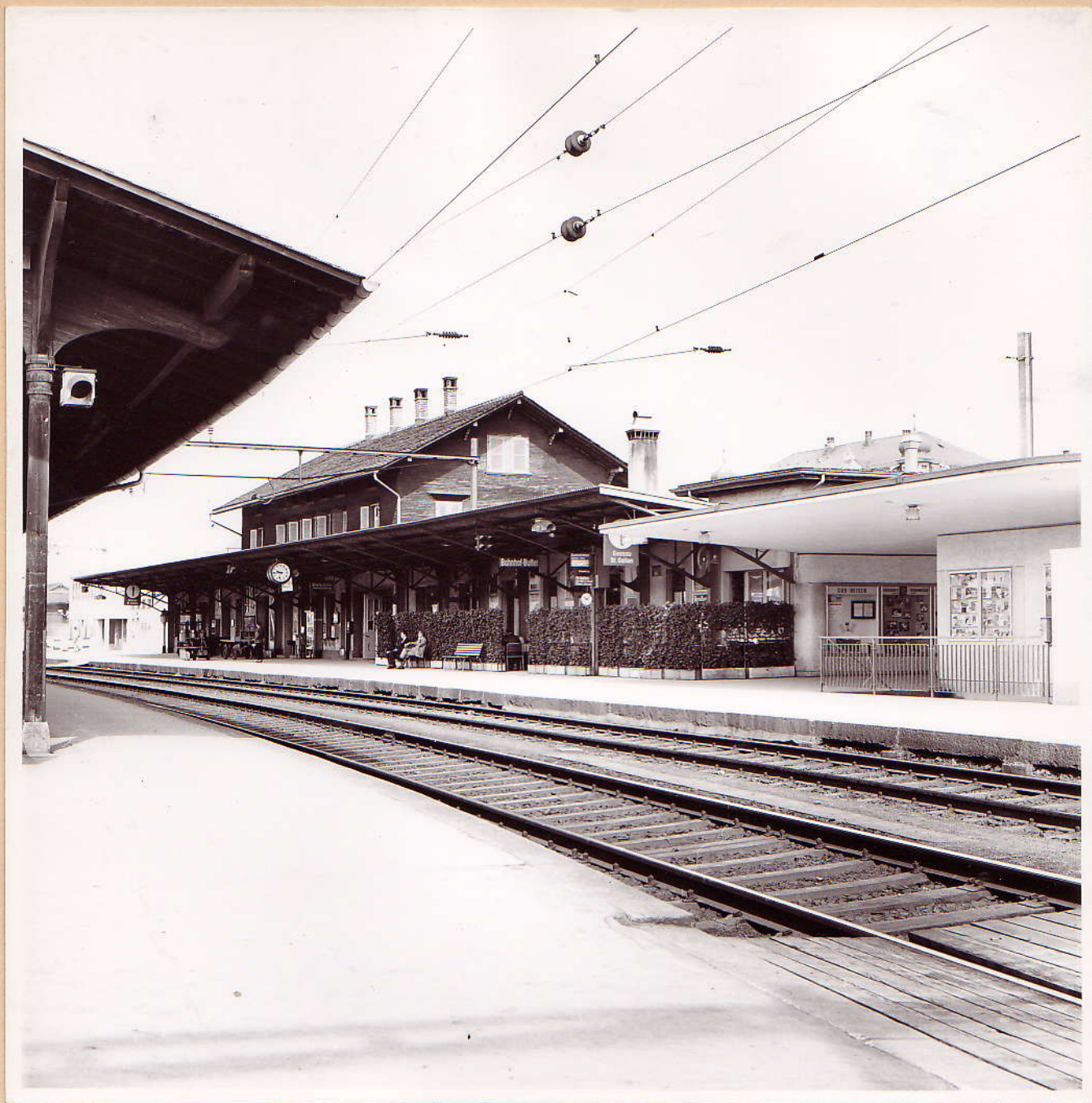
No. 11: Ansicht von SO,
