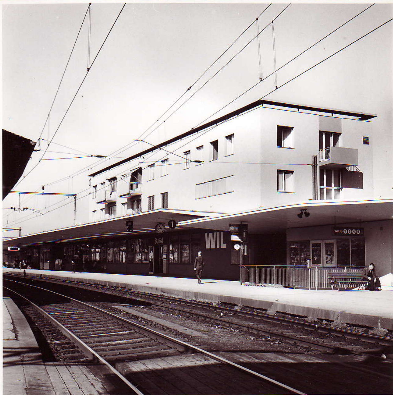
No. 111: Ansicht von SO.
