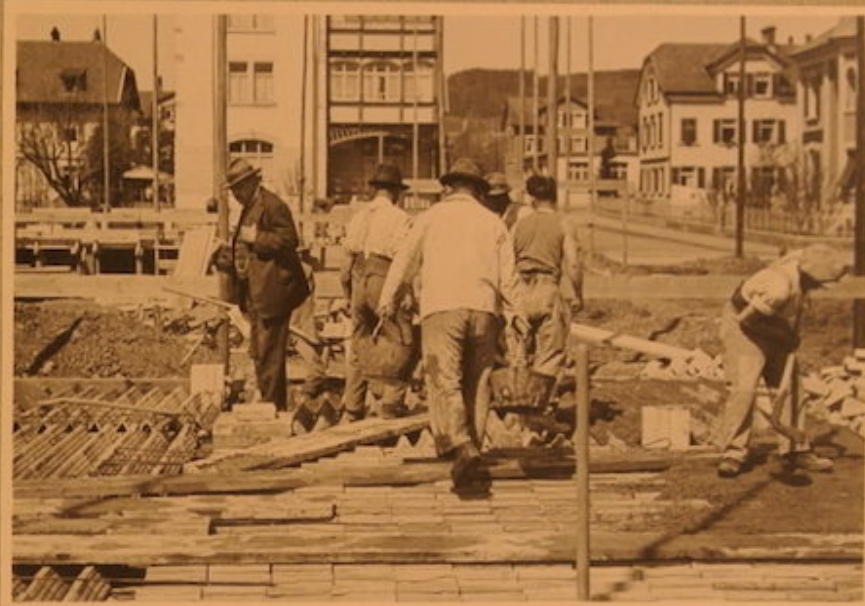
Betonieren der Berra-Decke — 25. 4. 33.
