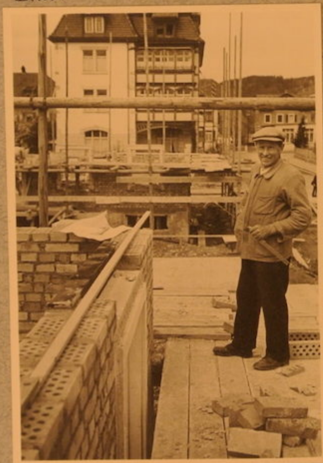
Zimmermeister Mayer bringt das Deckengebälk über Parterre.
