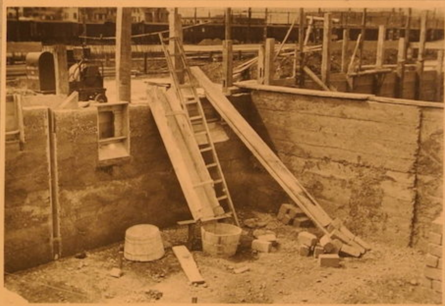
Die ersten Zementsteine in unserm Keller.
