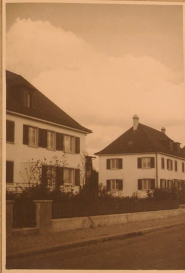
Bild nach Bauvollendung.
