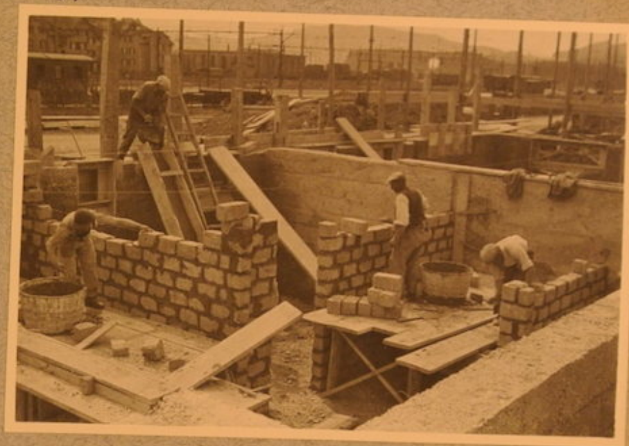
Aufmauern der Trennwände in unsern Kellern. 18. 4. 33.
