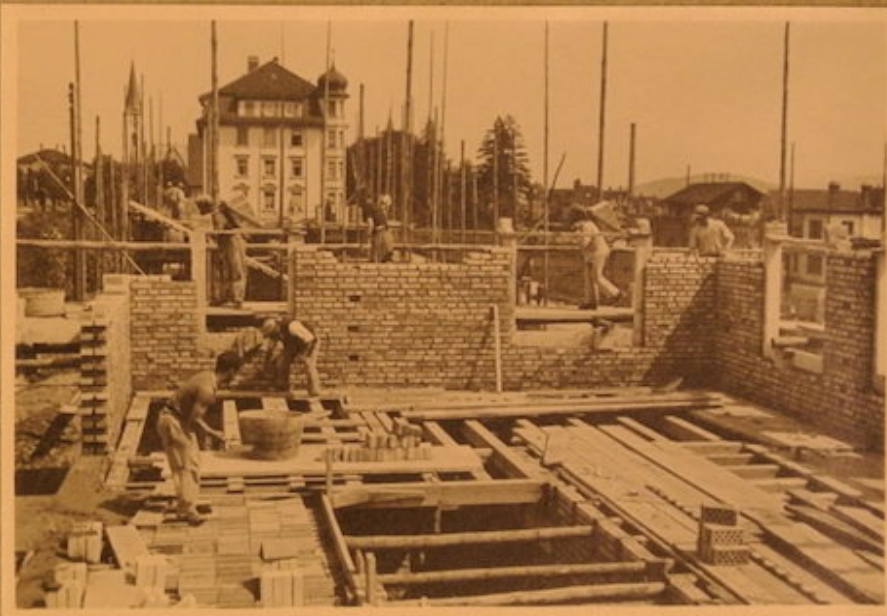
Aufmauern des I. Stockes.
