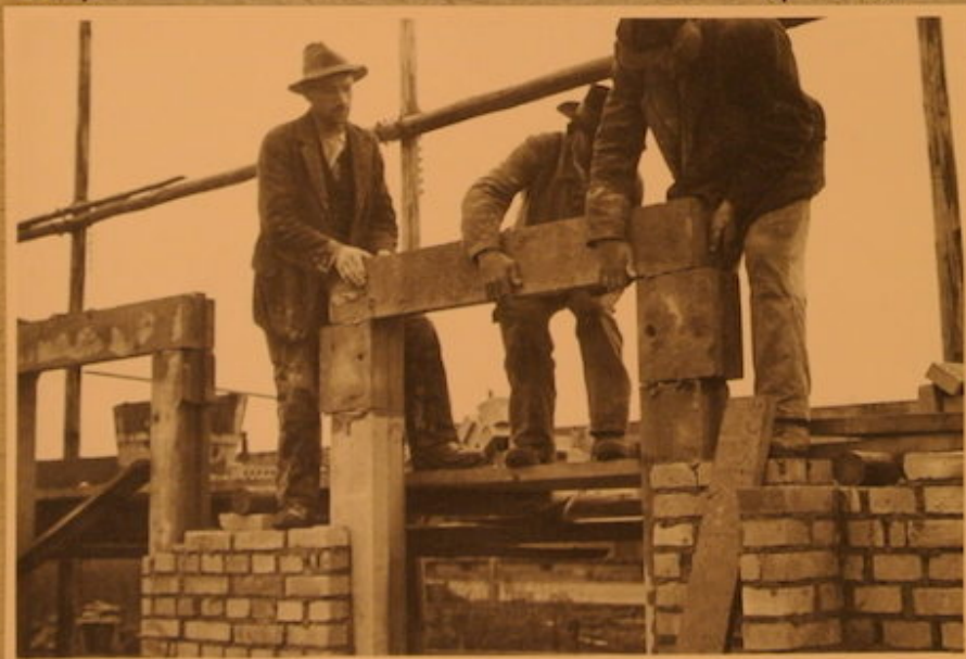
Auflegen des Sturzes der Terrassen-Türe Haus 6.
