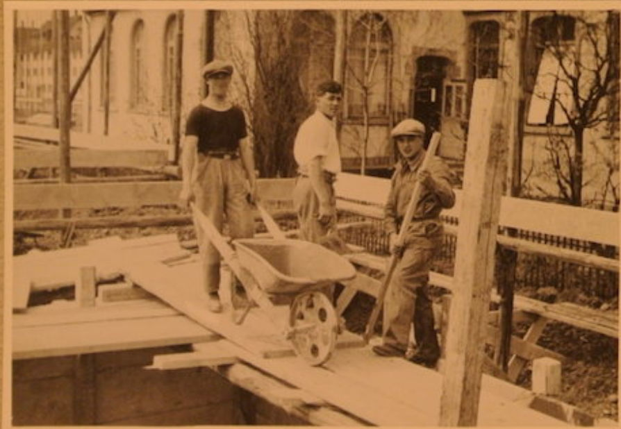
Zanotta's Leute beim Betonieren. Hs 2.
