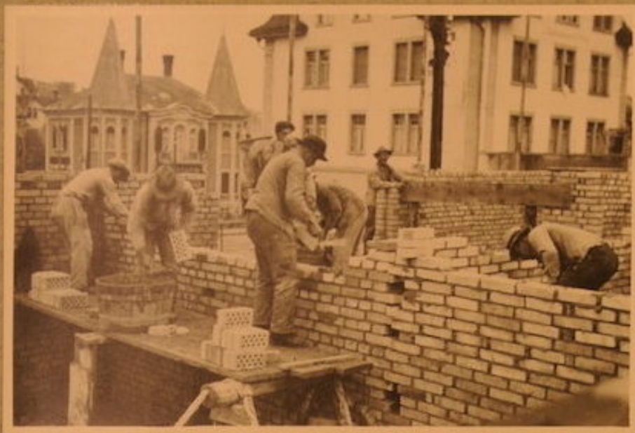
Die Trennmauern im I. Stock & zunächst die Brandmauer №. 5-6 in Arbeit. 9. 5. 33. von Süd-West
