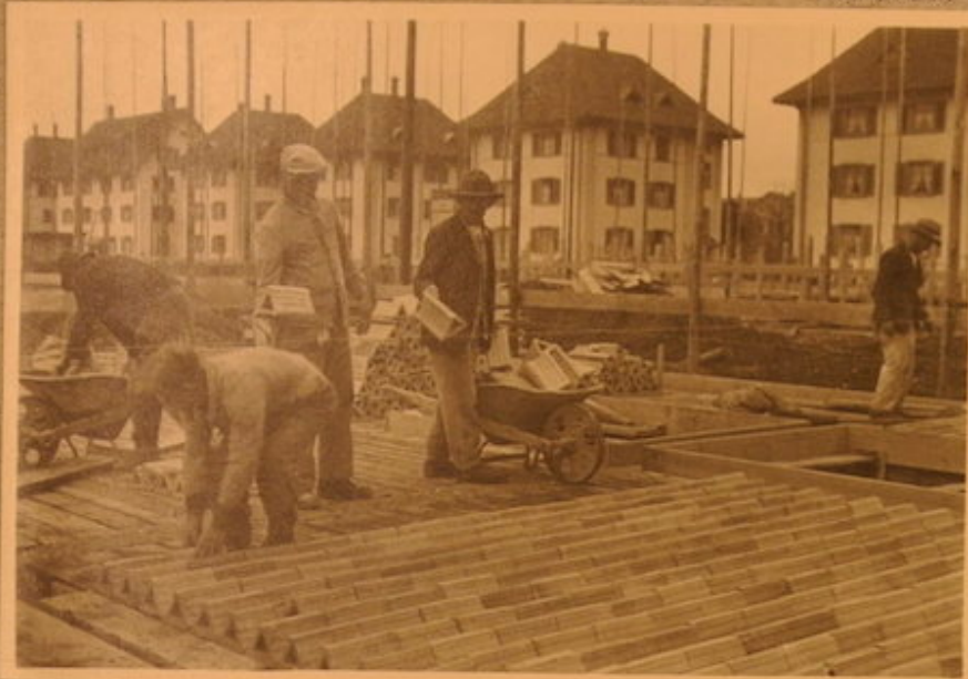
Verlegen der Holzziegel für uns. Berra-Decke.
