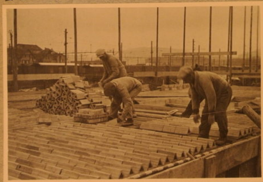
Verlegen der Kohlziegel für uns. Bertra-Decke.
