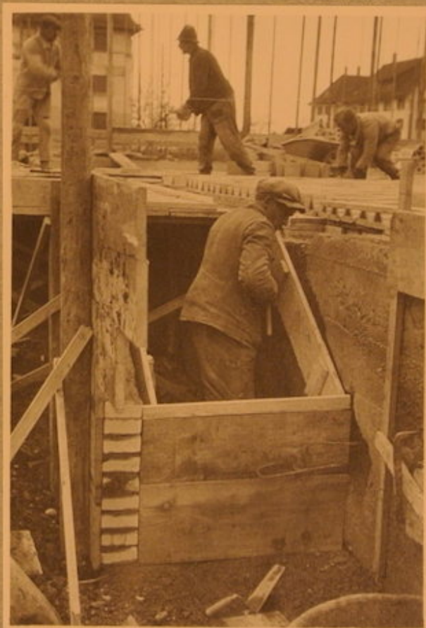
Schalung der Terrassen-Treppe.
