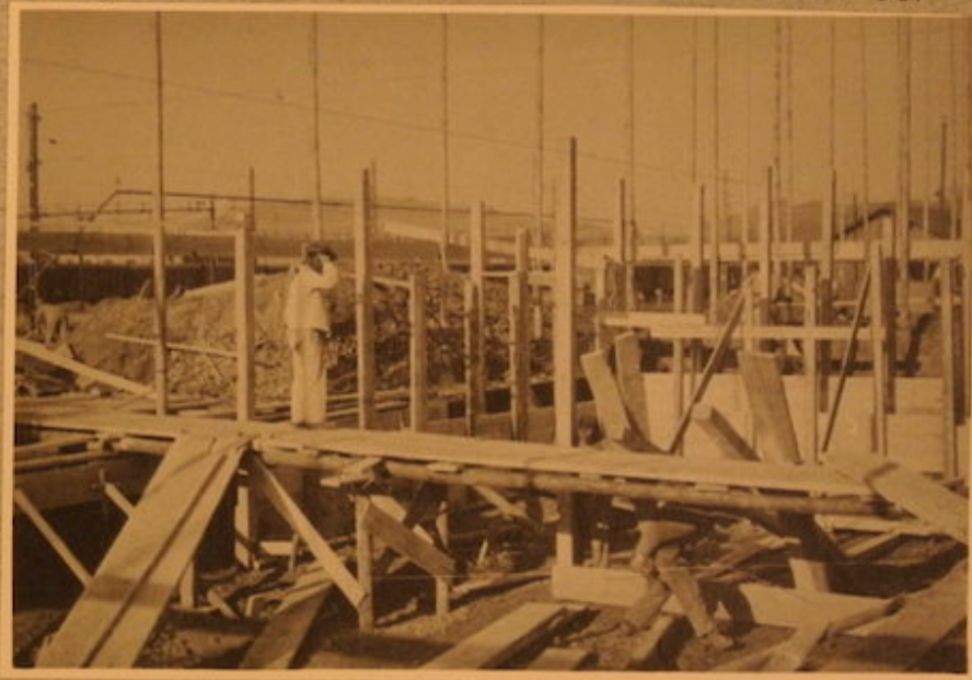
Verschalen für die Kellermauern. Hs. 5. & 6.
