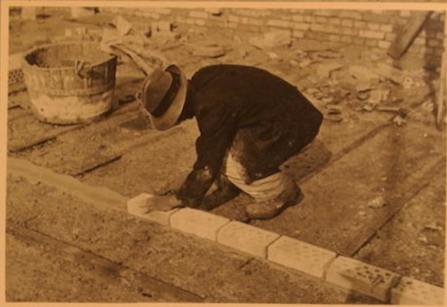
Die erste Steinlage für die Trennwand zwischen unsern beiden Stuben.
