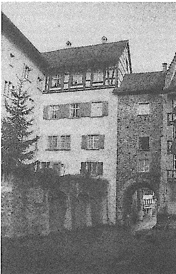
Haus Toggenburg mit Schnetztor
