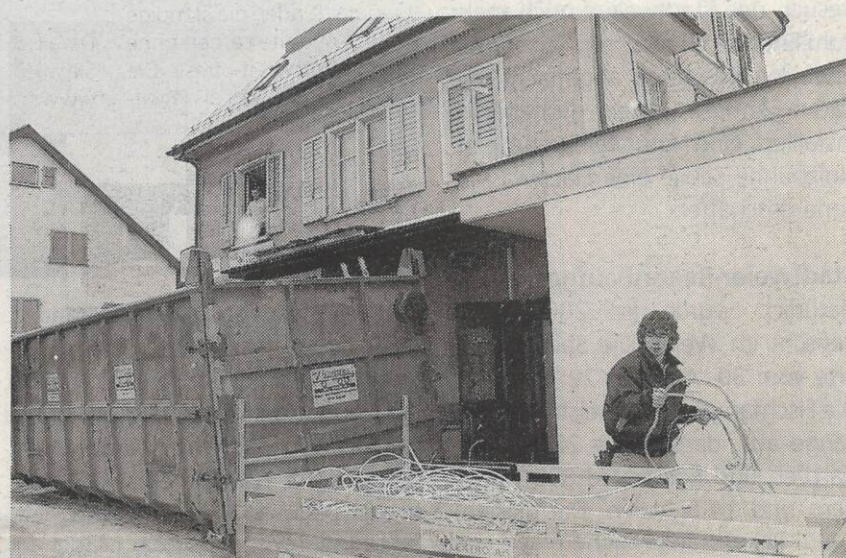
In diesen Tagen wurde mit dem Umbau des Restaurants Rebstock neben der Kreuzkirche in Wil begonnen.
