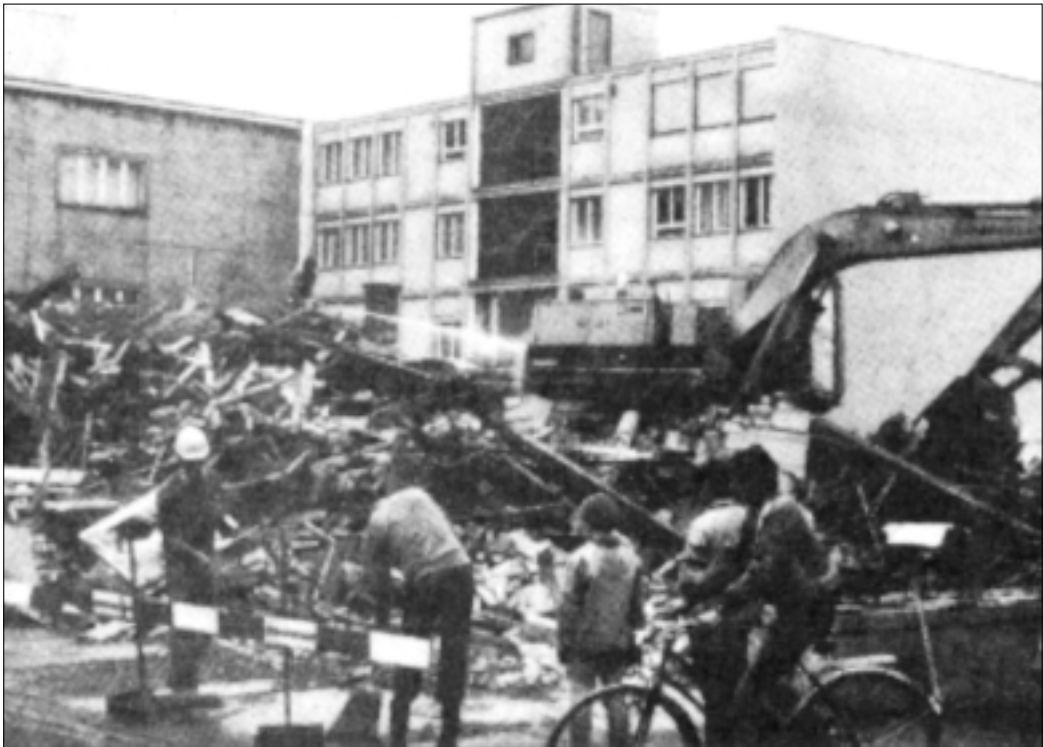
Anfangs Woche wurde am Bleicheplatz das Restaurant Dufour abgerissen. Das bekannte Konzertlokal muss einem Bank-Neubau der SBG weichen.
