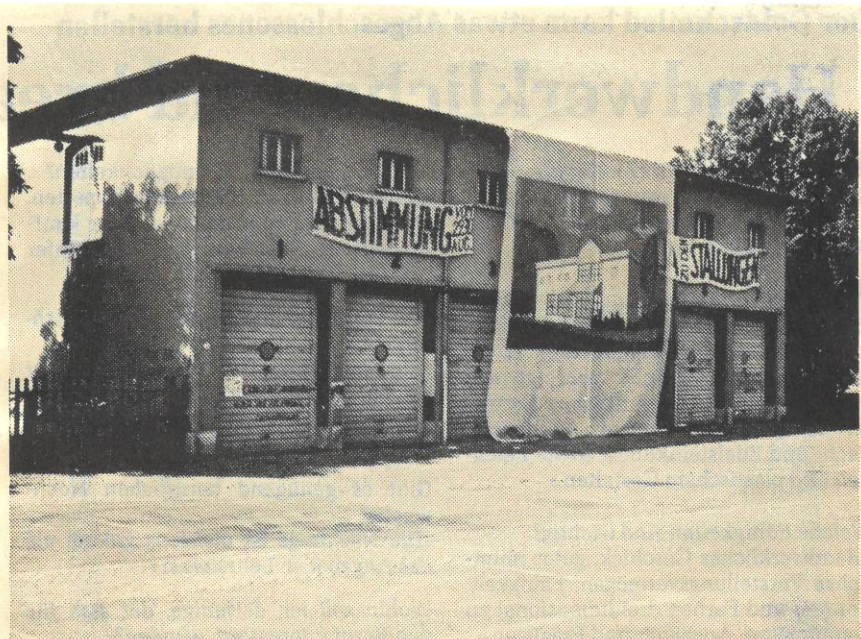
Mit Hilfe eines grossformatigen Transparents an der Frontseite des Garagetraktes an der Haldenstrasse wirbt der Verein «Kultur-Löwe» seit 7. August für eine Realisierung des Mehrzweckhauses «Sonnenhof».
