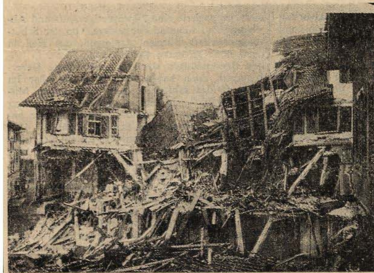
Es fallen die Mauern. Das traditionsreiche «Schöntal» im Abbruch
