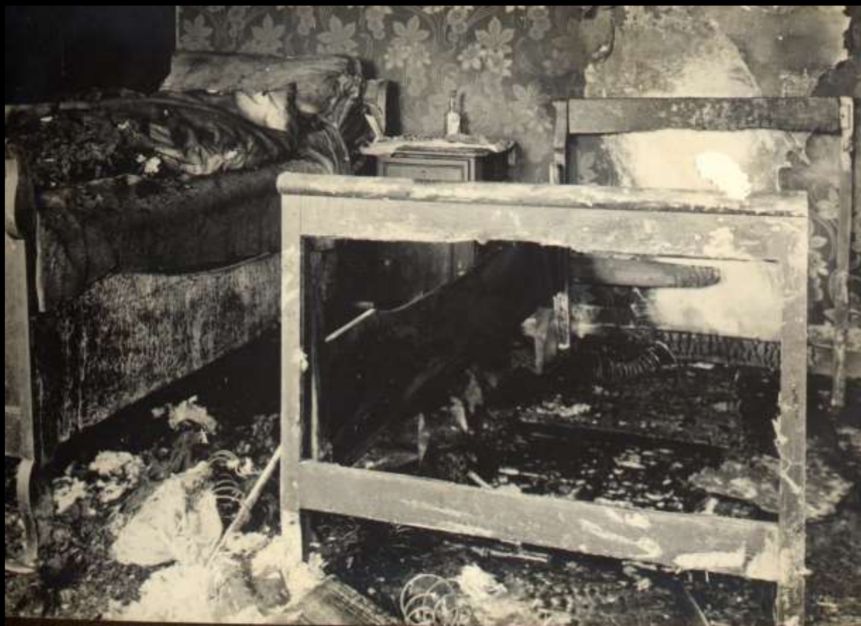
BRANDFALL HAUSER „GLÄRNISCH“ 19. APRIL 1917 SCHLAFZIMMER JANSEN
