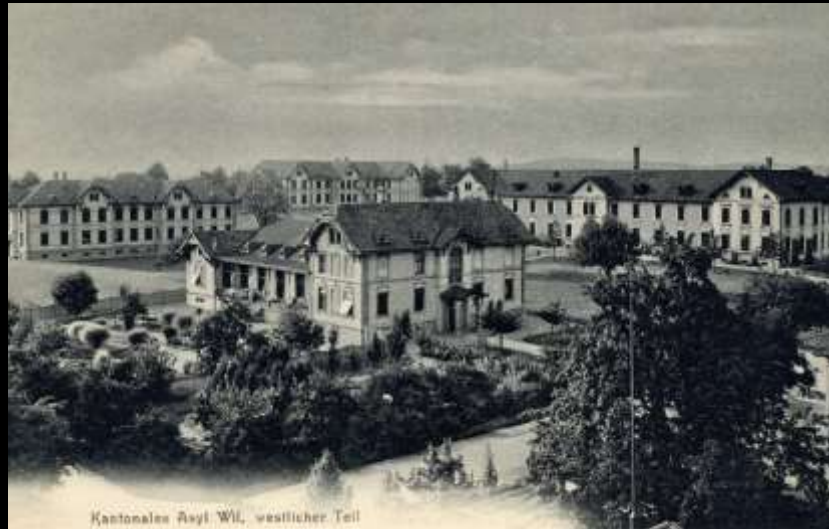
Kantonales Asyl Wil, westlicher Teil
