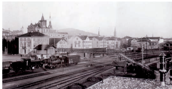
Am Wiler Bahnhof 1902. Eine Fussgänger-Passierelle führt über die Gleise. Links das Hotel Bahnhof, davor das sog. Wasserhaus, aus dem die Dampflokomotiven mit Wasser versorgt wurden. Im Hintergrund die Aktienbrauerei. (Foto Stadtarchiv Wil)
