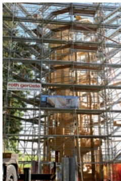
Der Wiler Turm im Bau, 18. Mai 2006 (Foto Wil Tourismus)
